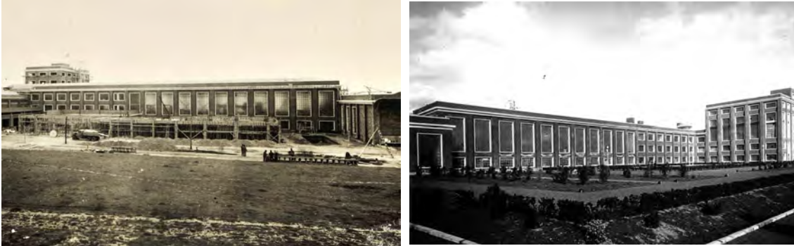
Fuente: colección fotográfica de la Fábrica de Papel y FotoFede. A la izquierda, la fachada trasera en 1950. A la derecha, la fachada a la calle en 1953, con Acabados a la izquierda y Semipastas a la derecha a su derecha.
