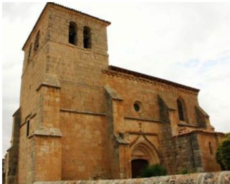
Exterior de Villovela de Esgueva con sus distintos contrafuertes
