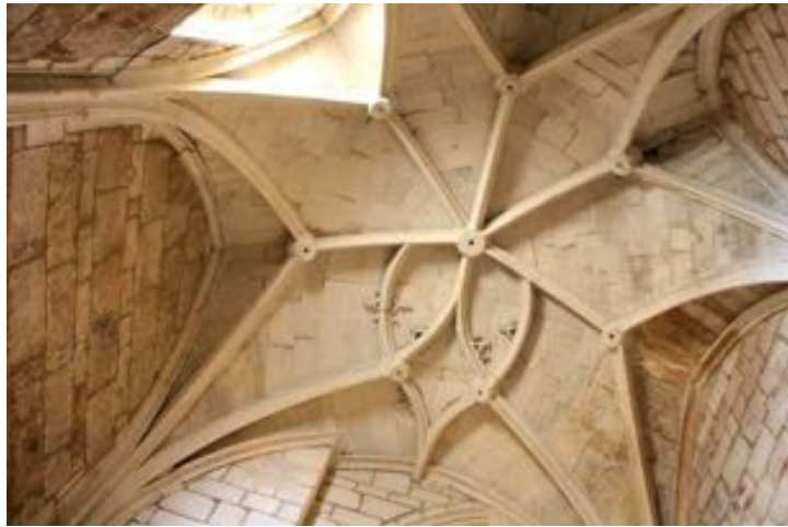
Bóveda con un doble combado en una capilla de Melgar de Fernamental
