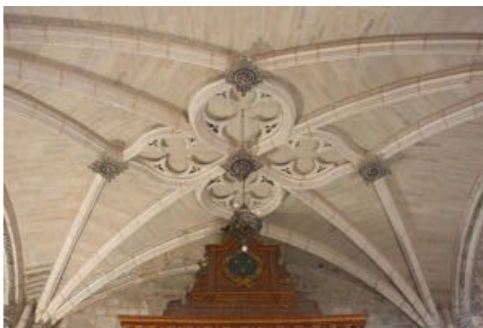
Bóveda de combados en el sotacoro de San Esteban de Burgos
