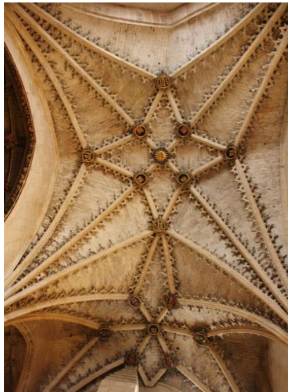
Bóvedas de terceletes compleja de la Capilla de Santa Ana
