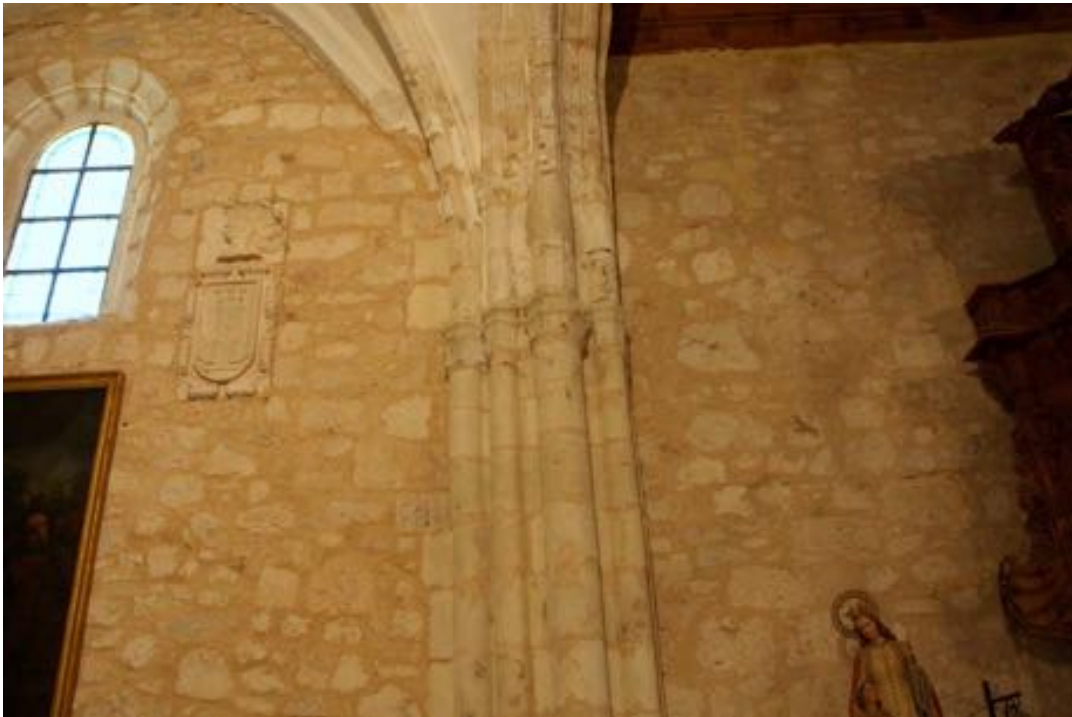
Vista del sillarejo en el interior de la iglesia de Haza
