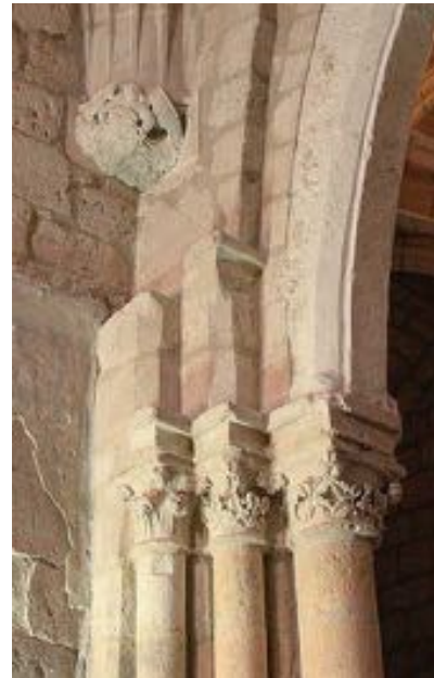
Una ménsula tardogótica junto con soportes anteriores en Torresandino
