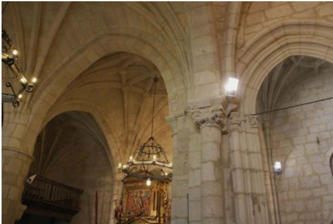
Vista de las naves de la iglesia de Susinos del Páramo
