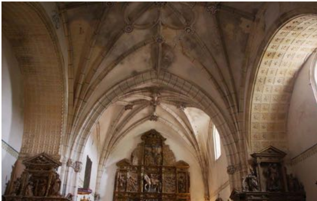
Vista de la cabecera de la iglesia de Villamayor de Villadiego
