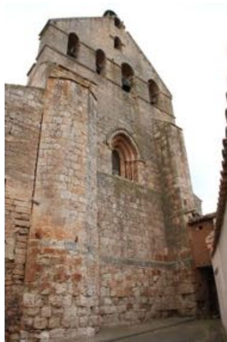
Espadaña de la iglesia de Presencio
