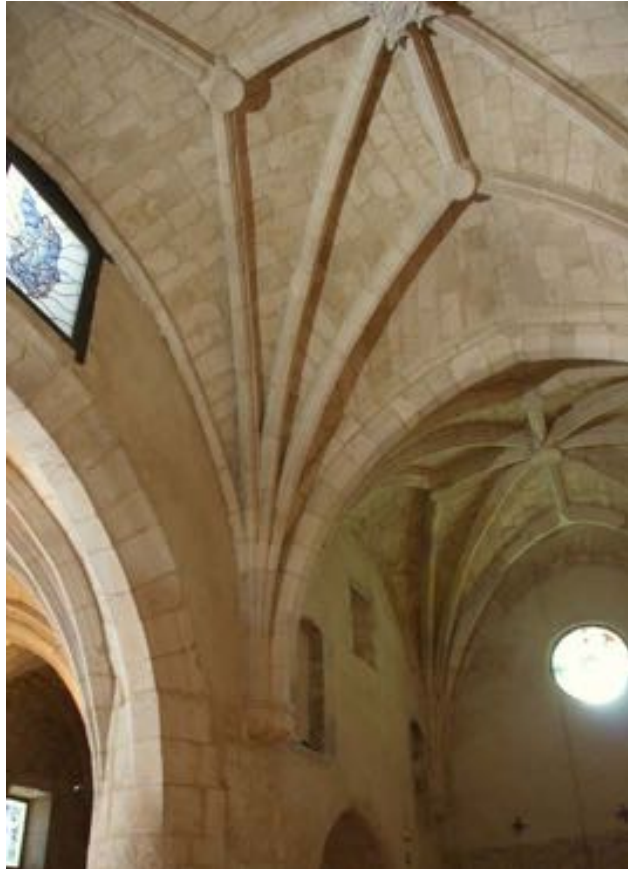
Vista de las naves de la iglesia de Valdezate
