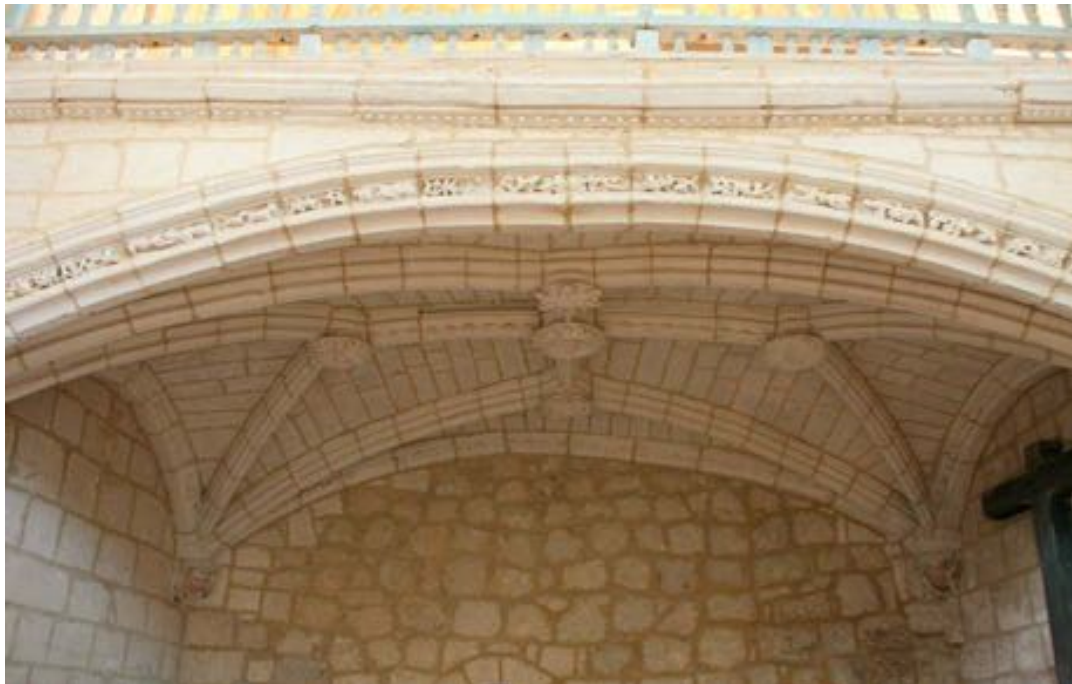
Vista de un pilar y algunas bóvedas de la iglesia de Hornillos del Camino
