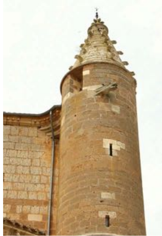
Contrafuerte circular con husillo en la iglesia de Melgar de Fernamental
