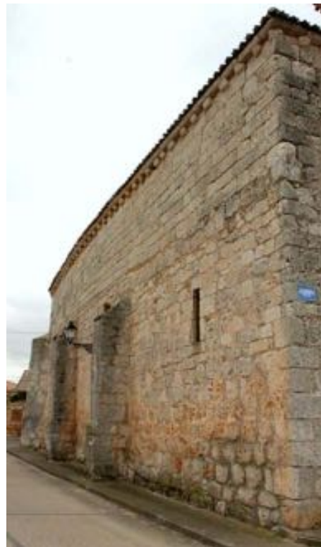
Lateral de Villamiel de Muñó con los contrafuertes mucho mas bajos que el muro
