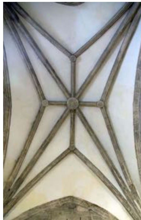
Bóveda de la Capilla de las Viejas en San Martín de Briviesca
