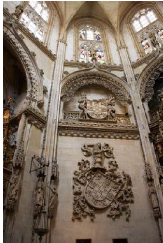
Vista del alzado de la Capilla de los Condestables
