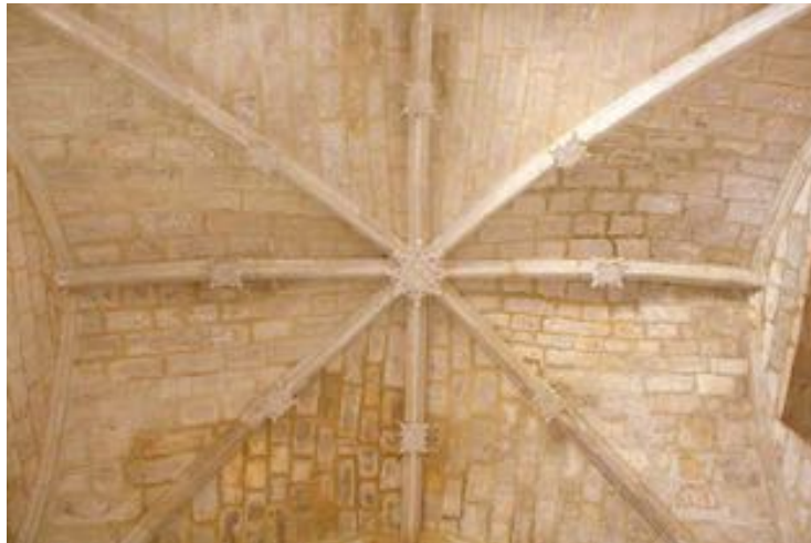
Una de las bóvedas octopartita de Sotragero
