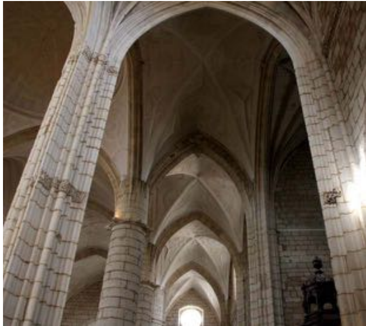
Pilar fasciculado con doble capitel en Melgar de Fernamental
