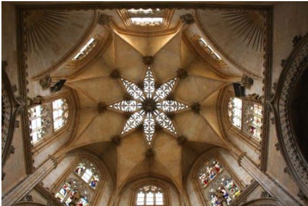
Vista de la bóveda calada de la Capilla de los Condestables de la Catedral de Burgos
