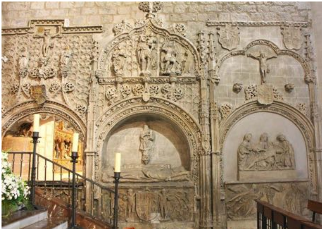
Arcosolios del ábside central de San Lesmes de Burgos
