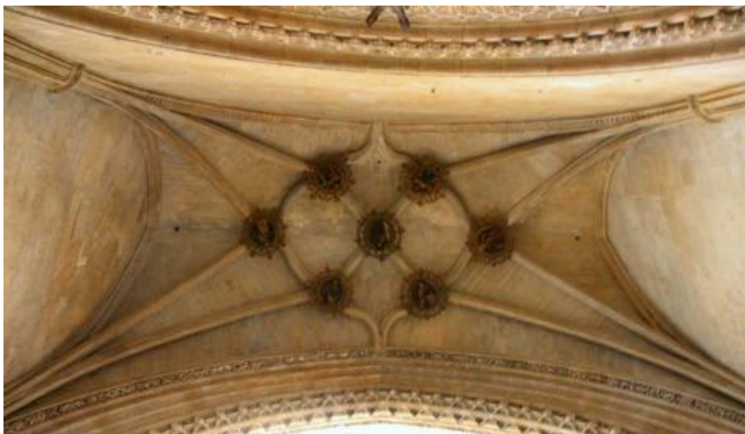
Bóveda del atrio de la Capilla de los Condestables, Catedral de Burgos
