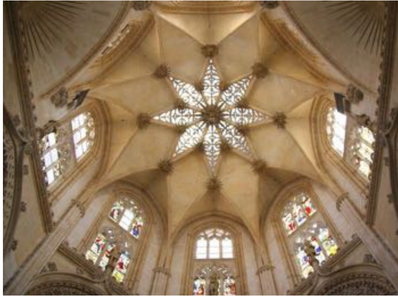
Vista de la bóveda de la Capilla de los Condestables
