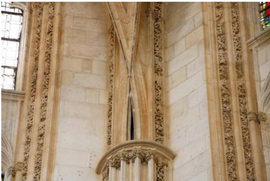
Jarjas dobladas de la Capilla de los Condestables de Simón de Colonia
