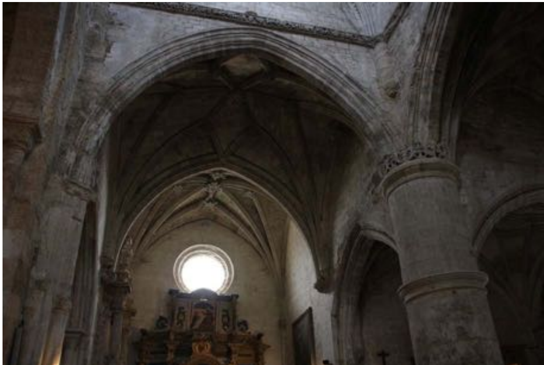
Vista del crucero de la iglesia de Arenillas de Riopisuerga
