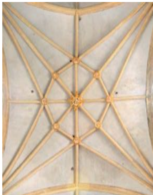
Bóveda de la nave de San Salvador de Oña
