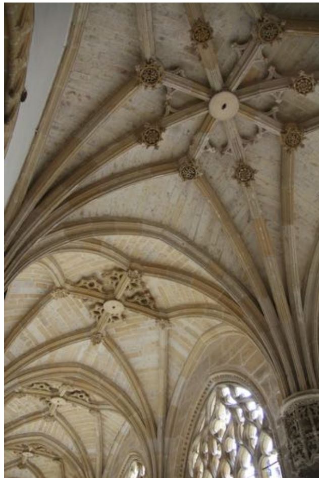
Bóvedas de terceletes del claustro de San Salvador de Oña
