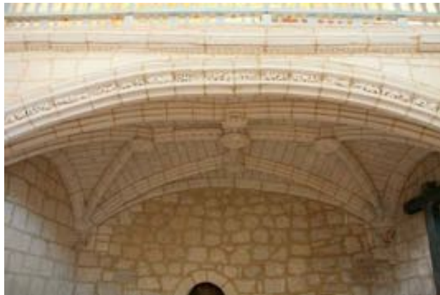
Vista del coro de Hornillos del Camino
