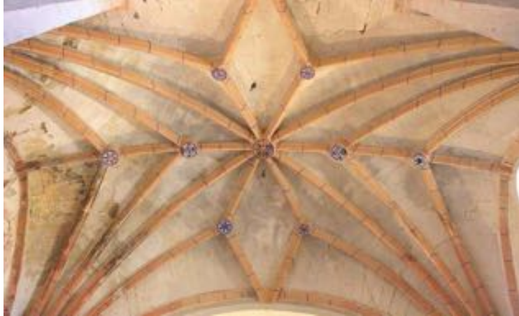
Bóveda de la nave de Lara de los Infantes
