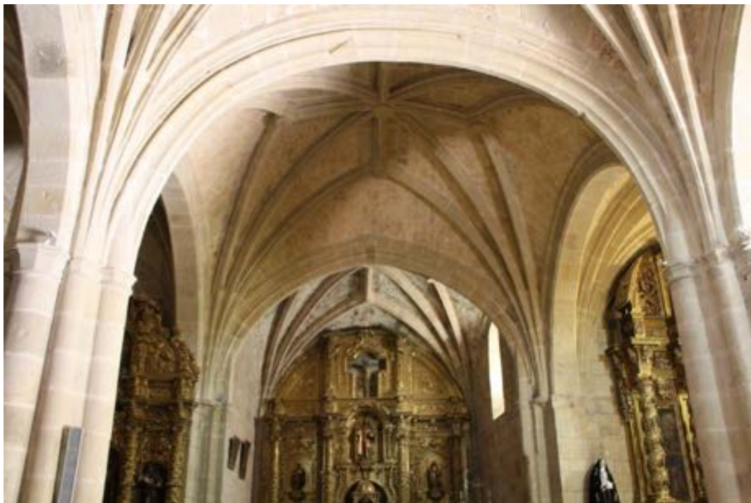
Vista de la iglesia de Castrillo de la Reina
