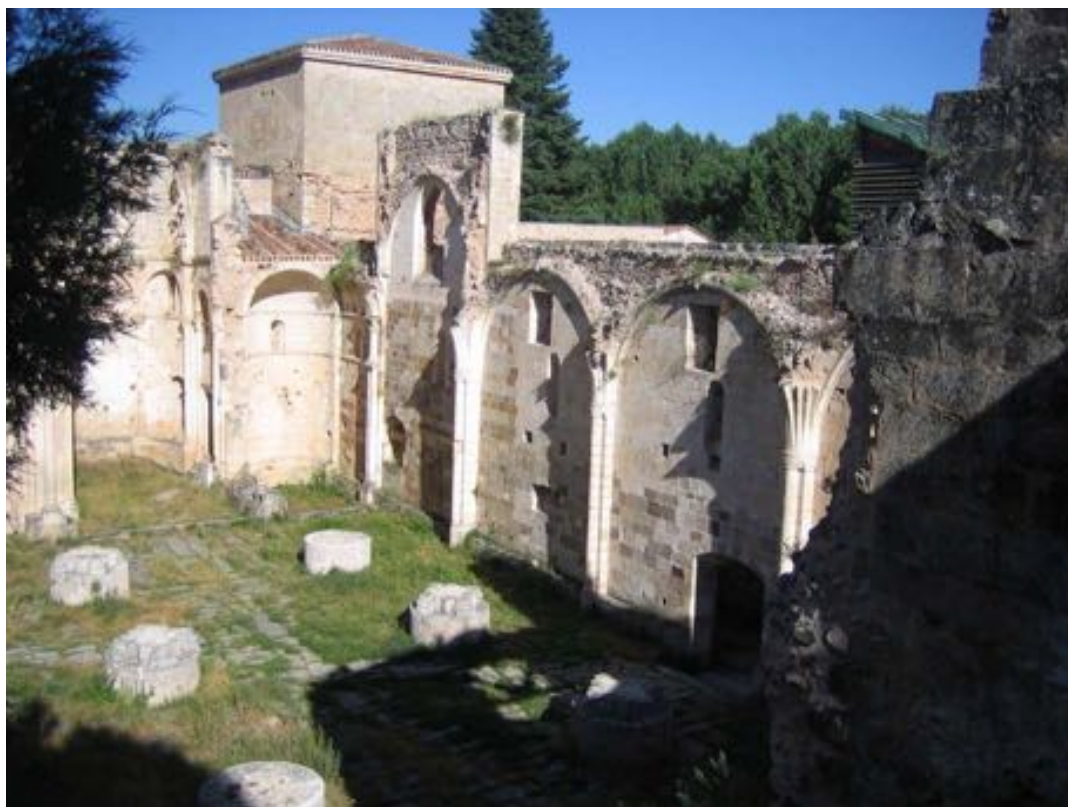
Vista de las ruinas de la iglesia del Monasterio de San Pedro de Arlanza
