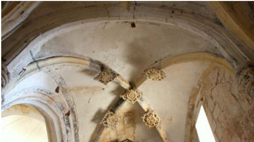
Vista de la boveda del abside de la Epistola de Castrillo Solarana
