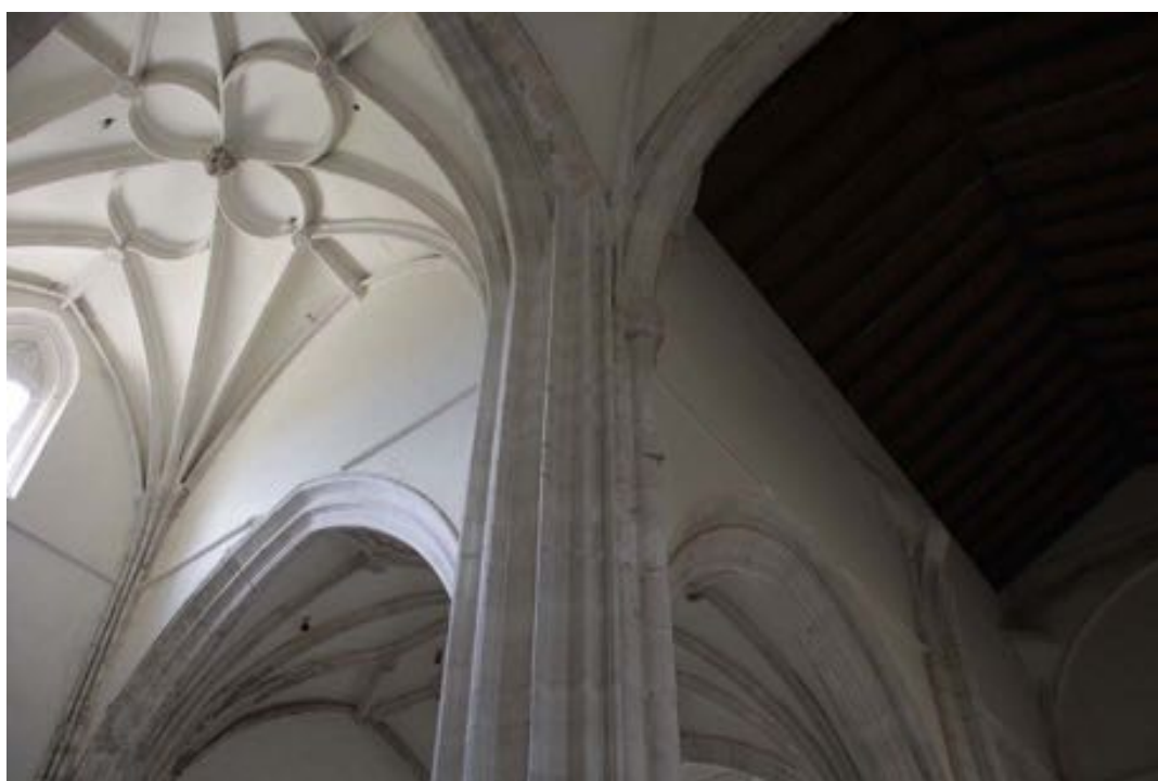
Vista de la nave lateral de la iglesia de Pedrosa del Príncipe
