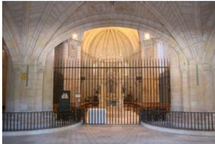
Vista de la iglesia de San Juan de Ortega desde las naves tardogóticas
