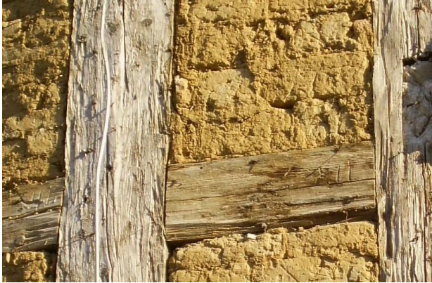
Fig. 370: Sistema constructivo Fachwerkwau: detalle. http://solar-sicherheit.de
