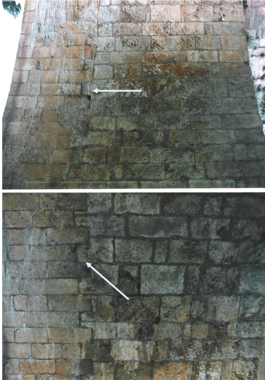
Fig. 248: Puente de Covarrubias, bóvedas arcos 1 y 2: señalada la línea de ampliación del s. XIX 859 . Agosto 1.997.
