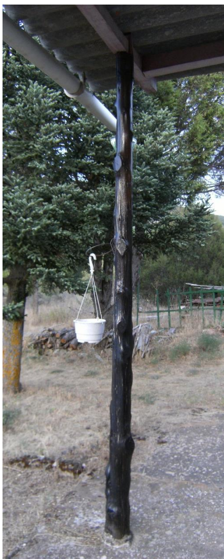
Fig. 112: Puntal de enebro tratado con aceite de creosota en una finca rústica. Covarrubias, Agosto 2.014.
