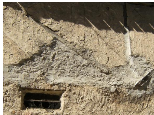
Fig. 359-360: Adobes dejados a "cara vista" en una reciente restauración, Calle del Puente, Covarrubias, y estructura de tapial en Cantalejo, Segovia. Abril 2.015.
