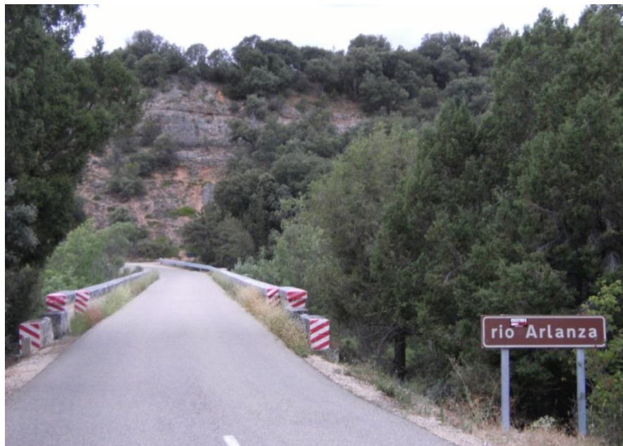
Figs. 79: Puente de Fuente Tubilla, sobre el Arlanza: carretera Covarrubias-Hortigüela. Agosto 2.014.
