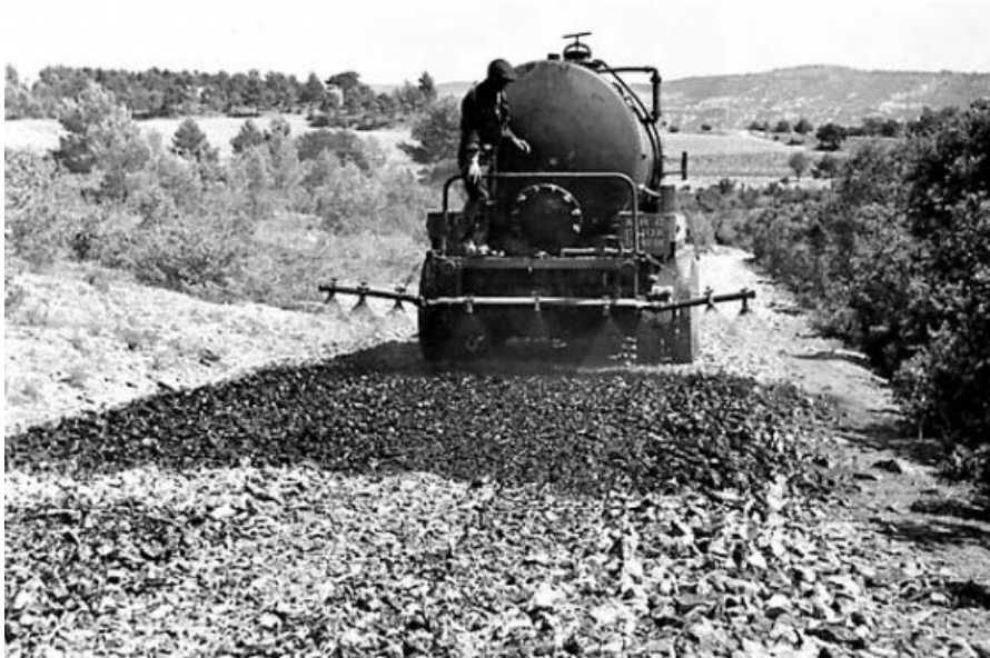
Fig. 39: Les routes en macadam: répandage émulsion, hacia 1.950 94 .
