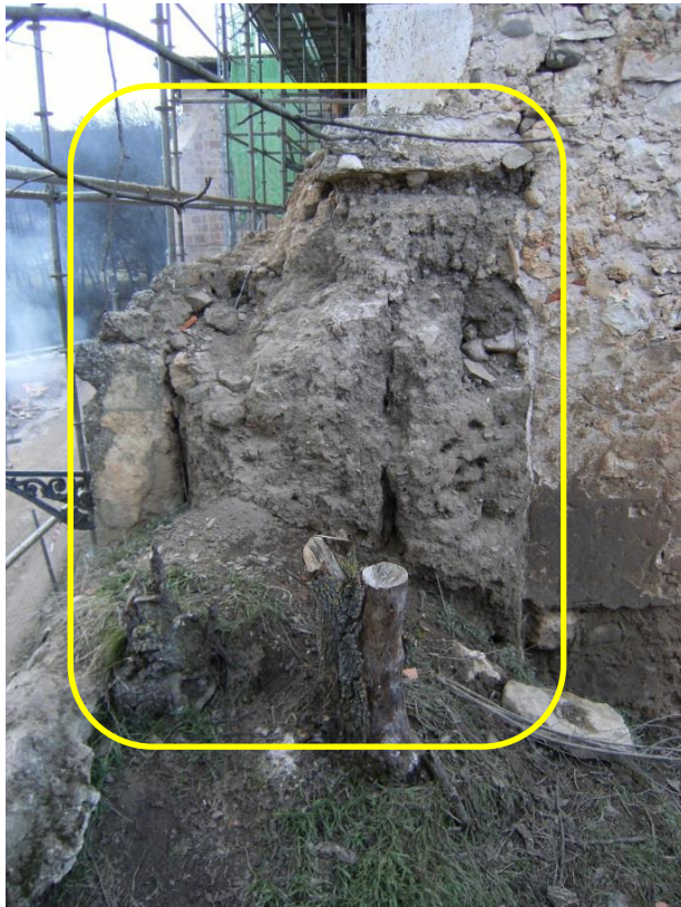
Fig. 216: Sección -restos- de la muralla bajo la sacristía de la Colegial, muro sur 640 . Febrero 2.015.
