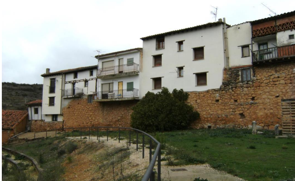
Fig. 244: Casas alzadas sobre la muralla hacia el Huerto de Dios , en su costado norte. Octubre 2.014.
