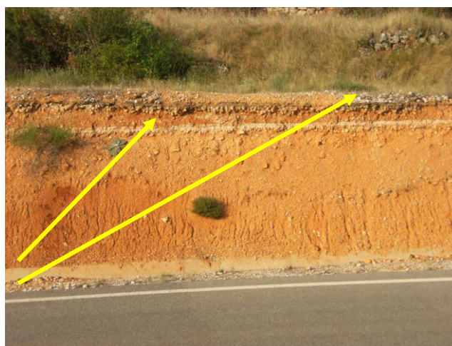
Figura45: Carretera BU-901, dirección Covarrubias, tramo de Las Arrevueltas : - Trazado antiguo y nuevo. - En la imagen inferior se observa el firme primitivo de macadam y los sucesivos firmes superpuestos.
