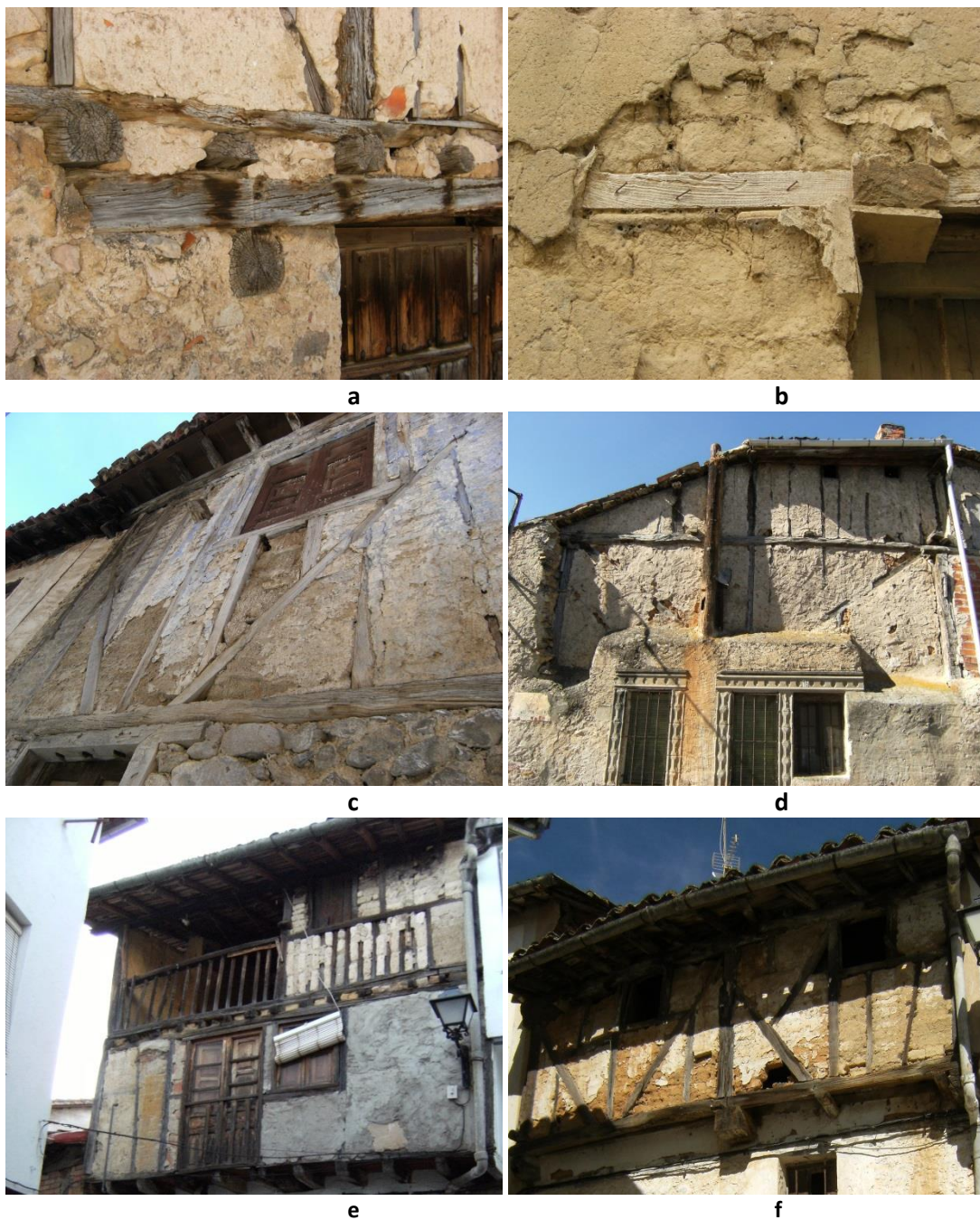
Lámina 53: Arquitectura de entramado: Noviembre 2.014 y Abril 2.015.
