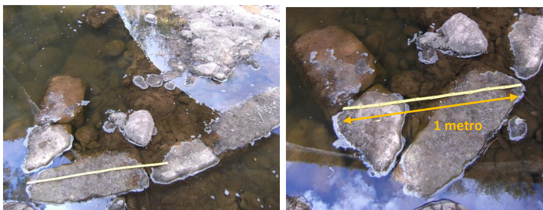
Fig. 139: Estructura de primitivo tajamar bajo arco segundo. Agosto 2.014.
