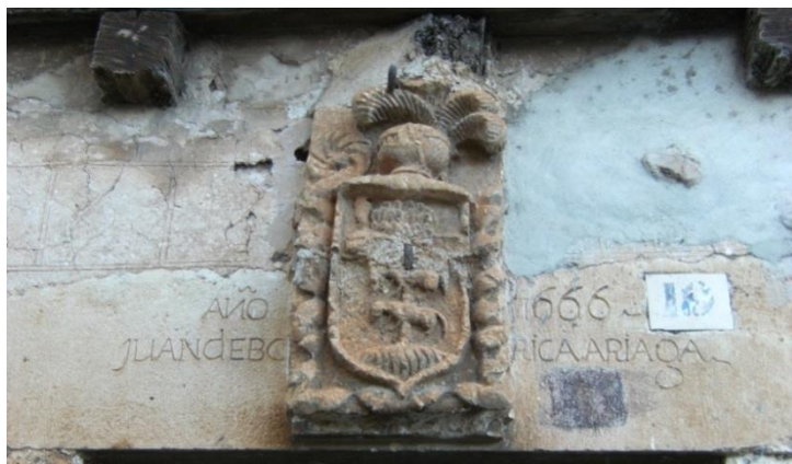
Fig. 393: Casa Borica Arriaga en Tenería Baja nº 10. Enero 2.015.
