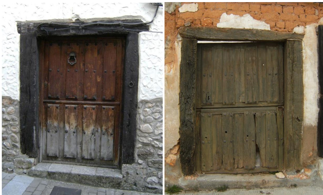
Figs. 398: Puertas tradicionales de doble batiente horizontal: Calles Puente y las Eras. Enero 2.015.
