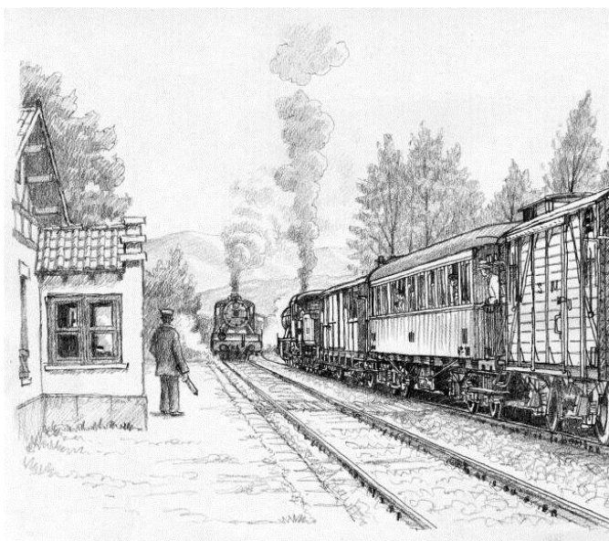
Fig. 46: Apeadero de Cascajares-Hortigüela:
