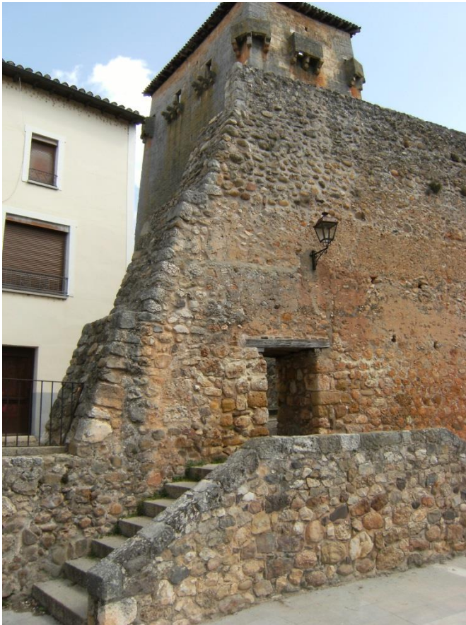
Fig. 214: Muralla y portillo a la Solana con el Torreón como fondo. Abril 2.015.
