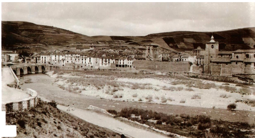
Fig. 250: Covarrubias: manguardía derrumbada en la salida hacia Retuerta. M o Santo Domingo de Silos.
