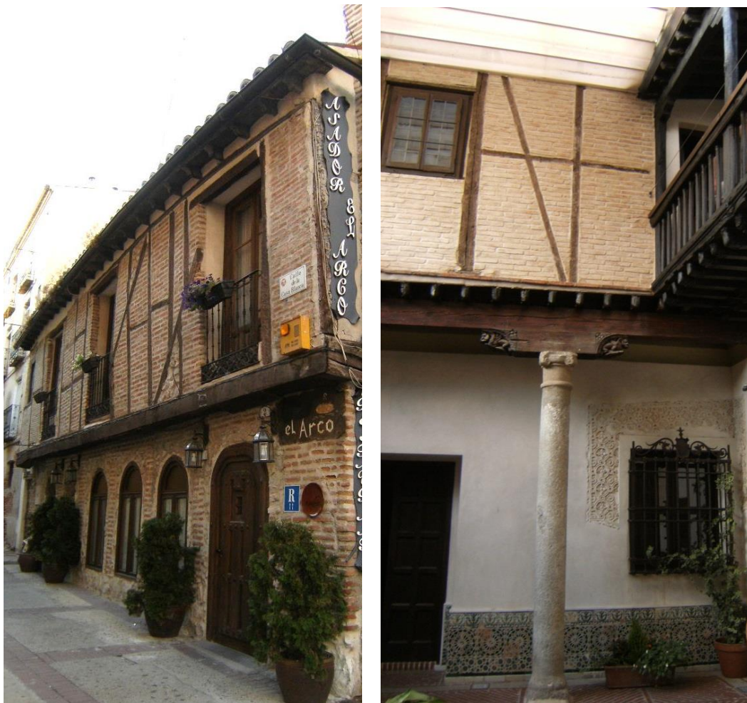
Figs. 381-382: Arquitectura de entramado en ladrillo: Arévalo y Toledo. Agosto-Septiembre 2.014.
