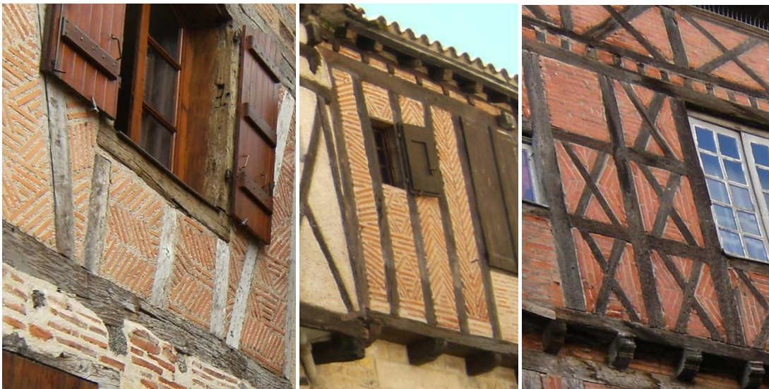
Fig. 380: Distintos tipos de ladrillo en entramado “a espiga”: Agen, Cordes Sur-Ciel y Albi. Julio 2013.
