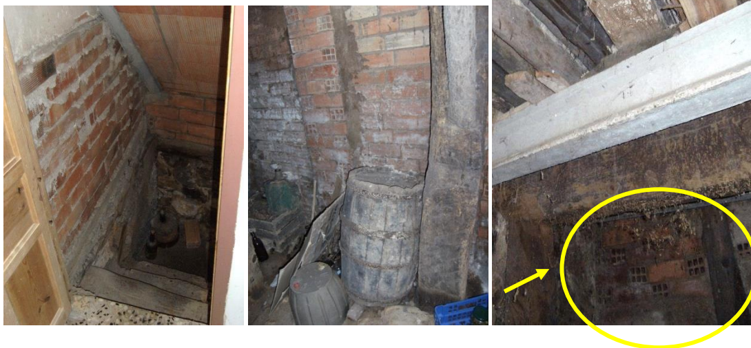
Fig. 398: Bodega de la casa n. 46 de la Calle de la Cuesta, después de la reconstrucción de 1.975: bajada, cubete junto a pie de enebro y techumbre original reforzada. La flecha señala la cueva que fue cegada.
