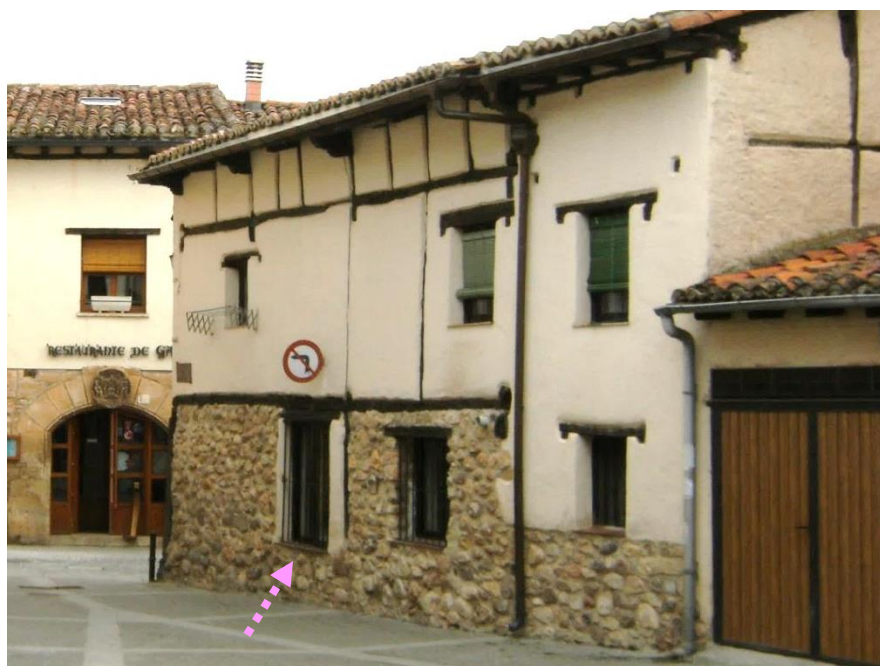
Fig. 399: Vivienda de bajo y alto, con entrada por calle del Archivo, nº 3. Vista de fachada lateral, a la calle de la Cuesta. La ventana señalada daba al taller de El Topete (escaparete). Marzo 2.015.
