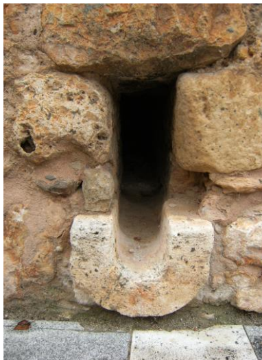
Fig. 285: Cara interior de la muralla en el costado sur y detalle de una boca de salida hacia el Paseo de la Solana.
