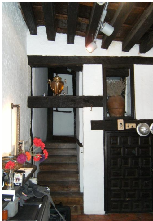
Fig. 340: Planta baja: interior y escaleras de acceso a piso superior. Julio 2.015.
