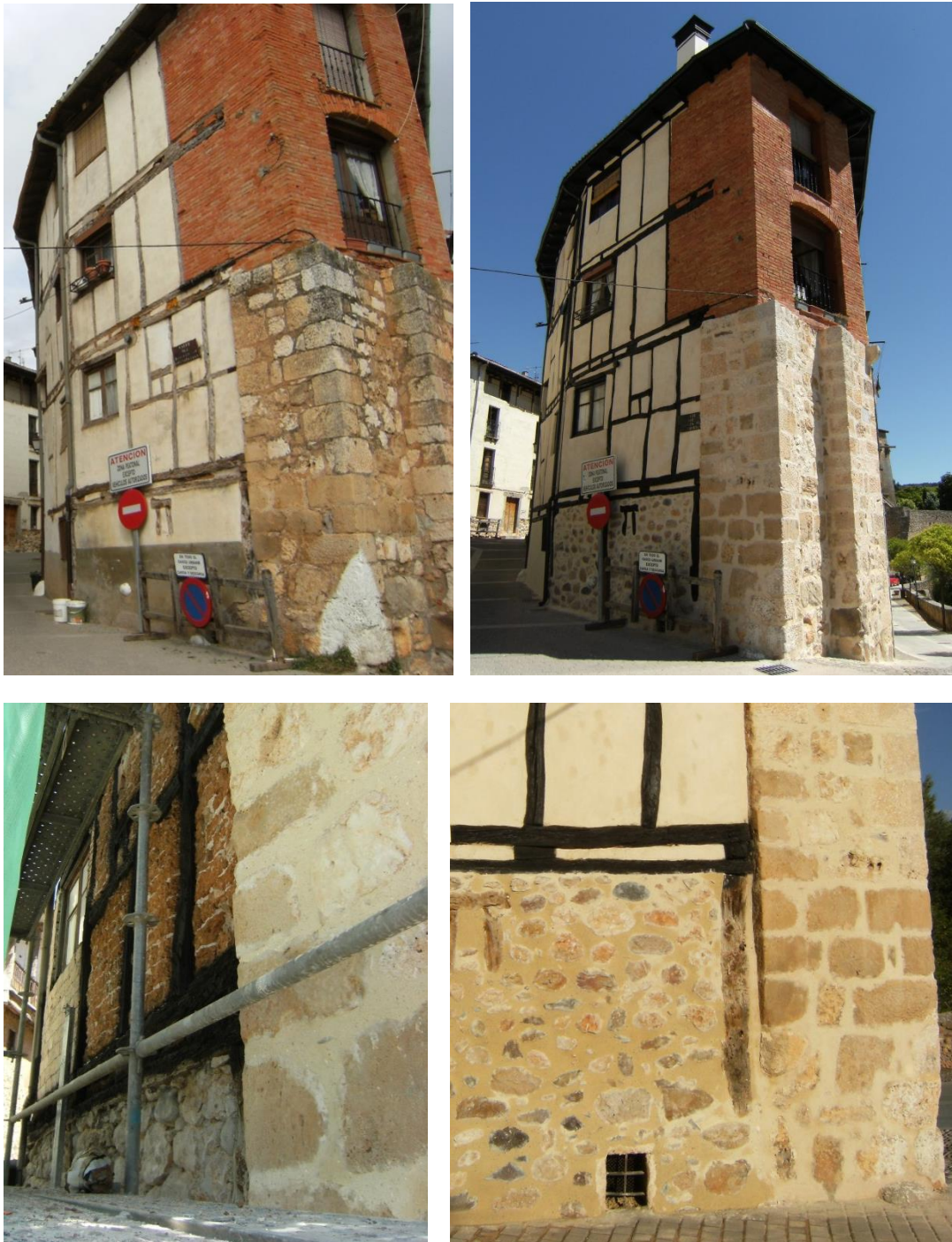
Lámina 61: Estado original, obra en proceso de ejecución y concluida: alzado y detalle. Calle Marqués de Covarrubias, nº 19. (Puente). Marzo-Julio-Agosto 2015.
