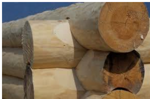
Fig. 369: Detalles sistema constructivo Blockbau 1191 .
