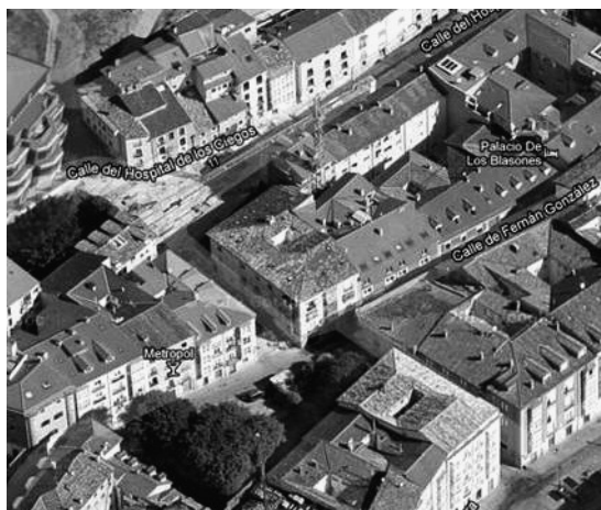
Apertura de este tramo de la calle de Hospital de los Ciegos en 1586, para poner en comunicación la calle San Llorente, actual de Fernán González, con los Barrios Altos
