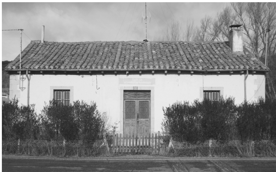
Fig. 3. Caseta del caminero de Puente de Dura. Jesús Borro Fernández (2017)
