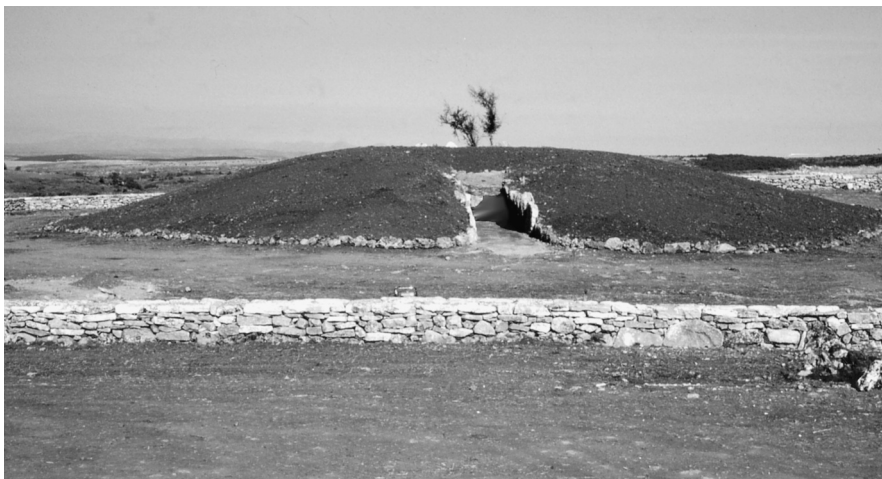
Obras de recuperación en el dolmen de Las Arnillas (Moradillo de Sedano): recreando el túmulo. En primer término la valla individualizadora del monumento
