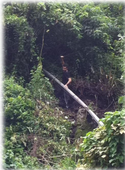
“Chapeo” (Desbroce y macheteo) de la capa vegetal sobre las visuales entre estaciones topográficas para su enlace.
