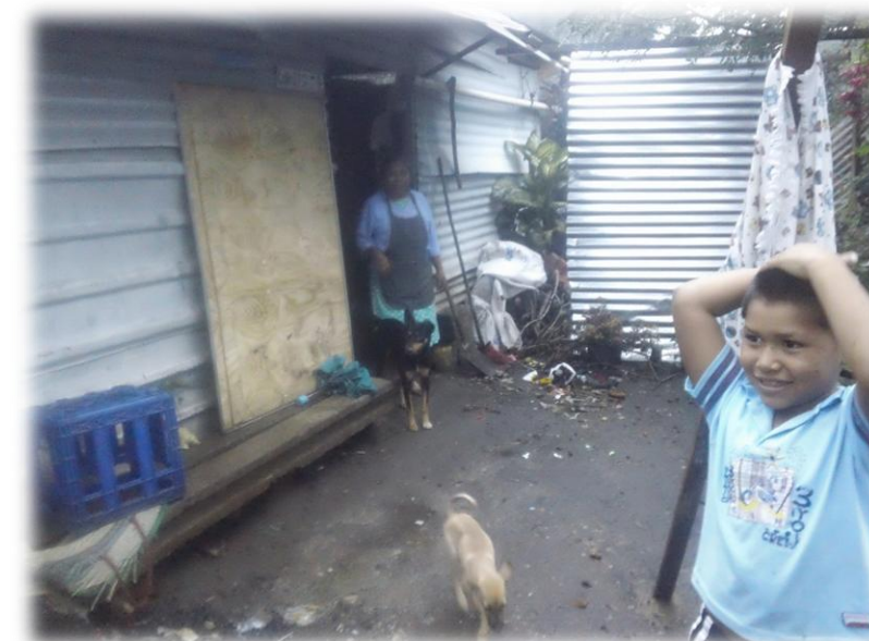
Muros de bloque y chapa son las paredes de la amplia mayoría de las viviendas. Inexistencia de pavimentado en la práctica totalidad de las calles de la aldea.
