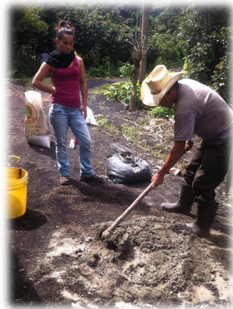
Hormigonado de un mojón para la referencia topográfica.
