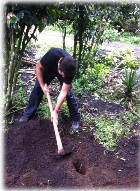
Desbroce a mano de la capa vegetal del terreno
