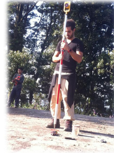
Estabilización del prisma en el depósito de la antigua línea de abastecimiento.
