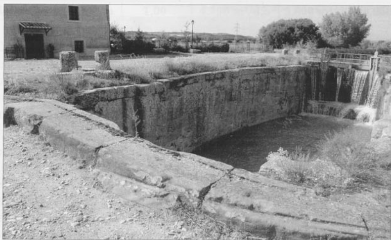
Esclusa del Canal de Castilla fabricada con la misma roca arenisca roja que el canal romano de los Anillos de Sasamón. Este lugar es cercano al de la cantera, en Herrera de Pisuerga (Palencia)
