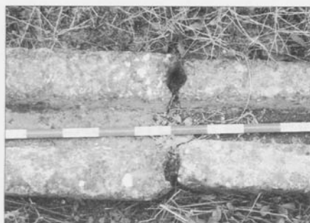
Canal de Andelos (Navarra), con detalle de la junta de estanqueidad
