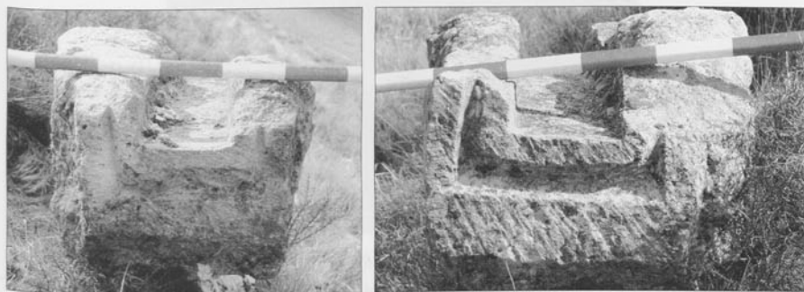
Piezas de canal tallado en piedra caliza del acueducto romano del Arca, en Sasamón. Se observan los entalles de la junta de impermeabilización en los que falta el mortero (opus signinum)
