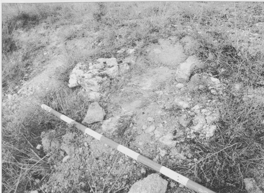
Trozo de canal aflorando del terreno con el mortero impermeabilizante en su fondo
