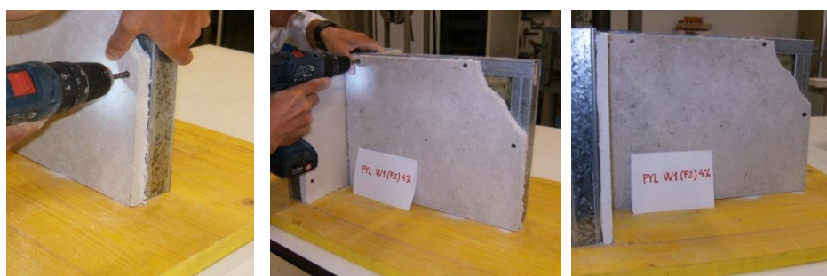
Imagen 9.5. Colocación placa PYL W1 (F2) 4%
