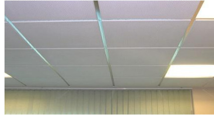
Imagen 1.12. Placa de escayola desmontable para techos suspendidos
