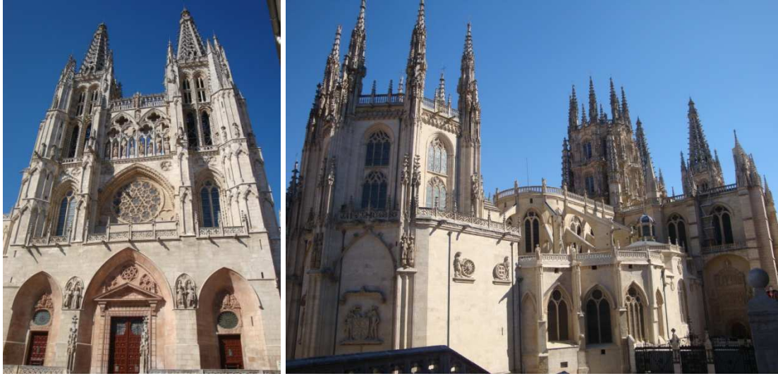
Izq.: Puerta de Santa María. Der.: Vista actual desde la calle Fernán González. Fotografías de la autora.
