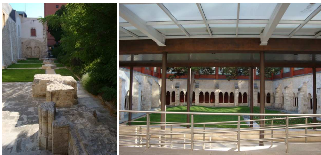
Izq. Restos de la Iglesia. Der. Vista del claustro en la actualidad. Fotografías de la autora.
