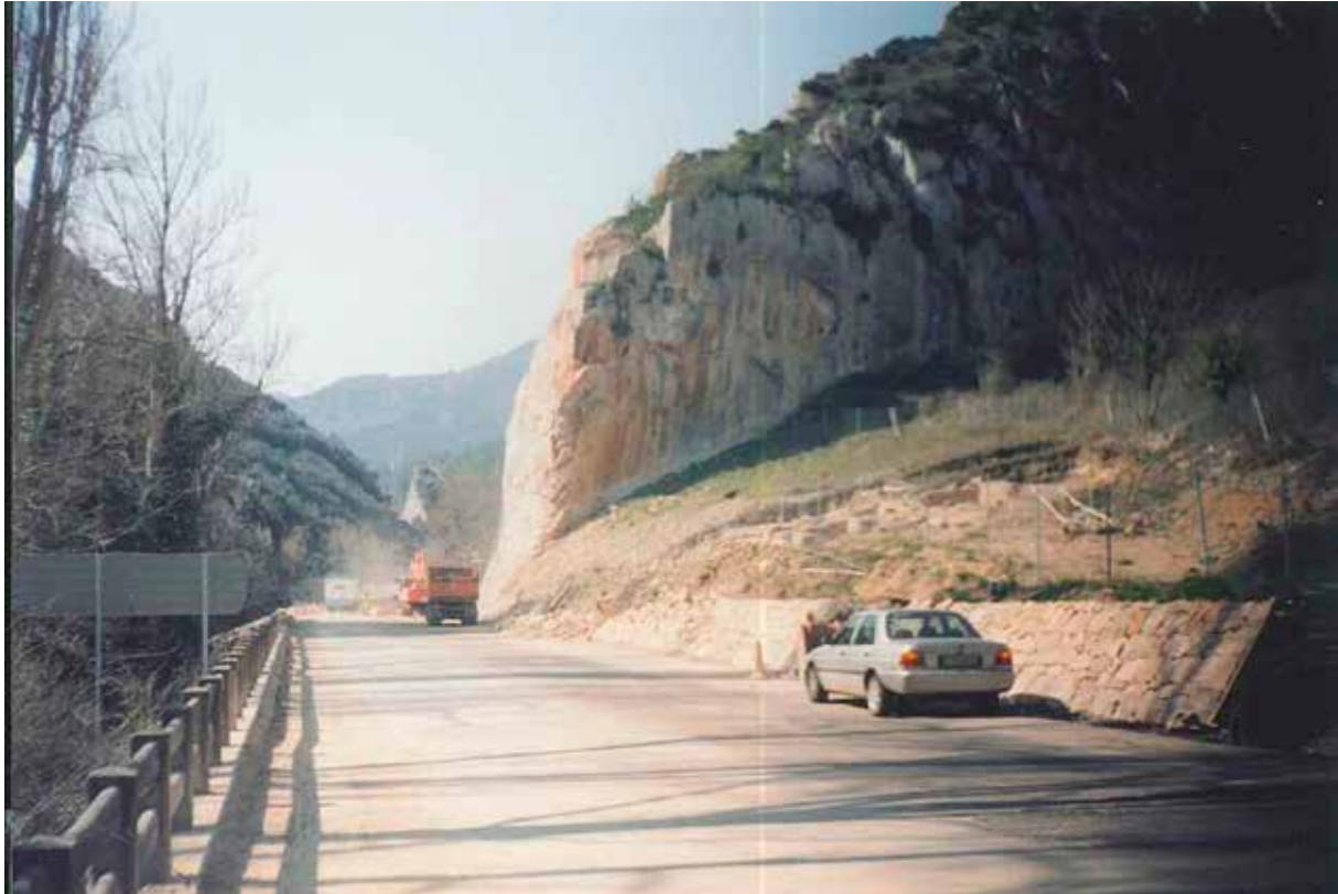
123. Fotografía. Vista de Peña Partida desde la carretera N-629, dirección Oña, después de la voladura.
