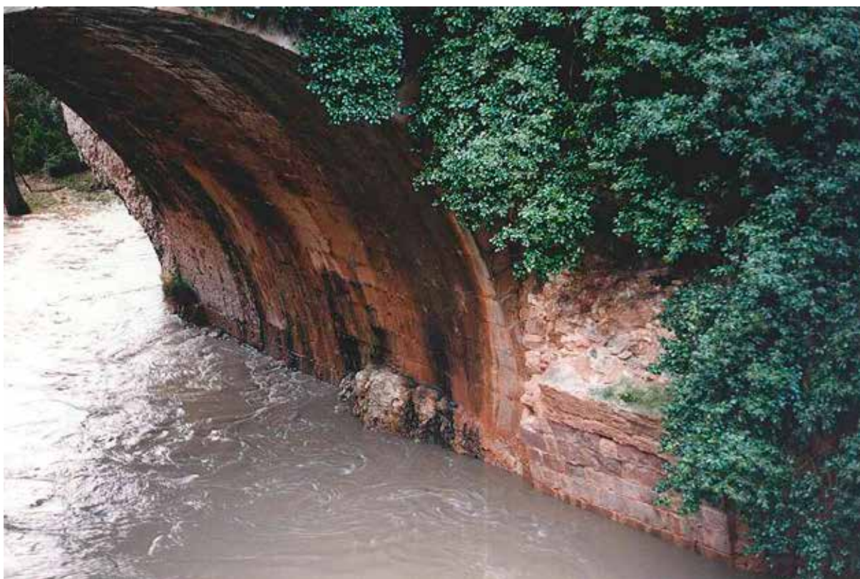
6. Fotografía. Detalle, en el mismo puente, de una construcción anterior.
