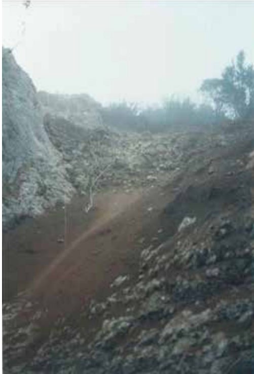
125. Fotografía. Vista del muro (u.e. 5) de la turrís de Peña Partida durante la intervención. La torre no requirió de muchos más alzados pues, como puede verse en la imagen, uno de los laterales queda delimitado y “construido” por la propia roca del crestón, mientras el opuesto, sobre Sta. María de los Reyes Godos, el cortado hace innecesaria otra obra y, por el lado contrario al muro que aquí se ve, es decir, en la parte alta del crestón, el muro es una simple tapia de mampostería.
