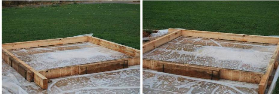
Imagen 7.2 Encofrado de losas exteriores
