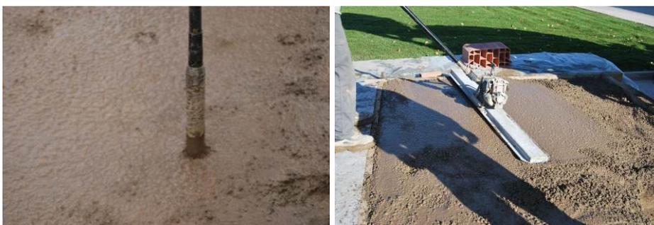
Imagen 7.4 Sistemas de compactación utilizados en las losas
