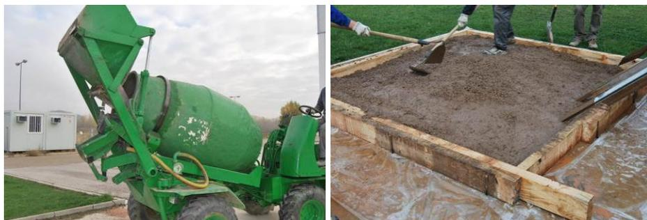
Imagen 7.3 Hormigonera autopropulsada empleada y vertido por gravedad del hormigón
