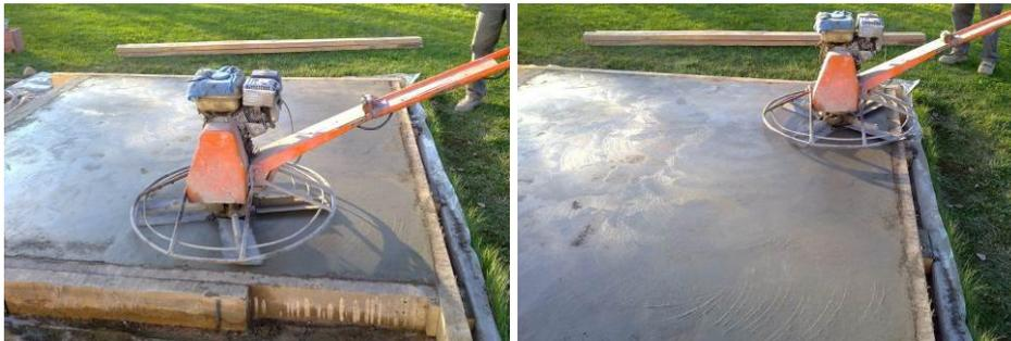
Imagen 7.6 Fratasado con helicóptero en las losas
