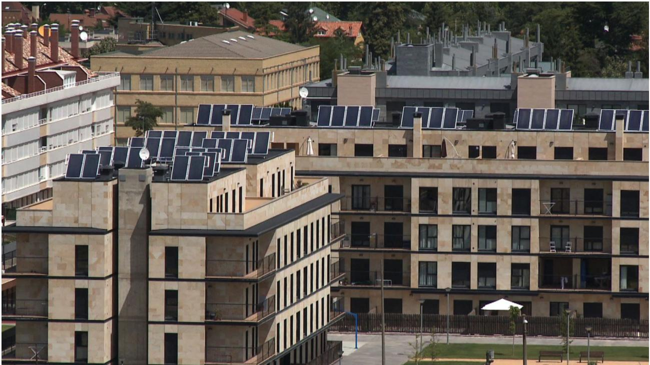
La utilización práctica de sistemas de energía solar térmica de baja temperatura en la edificación consiste en el aprovechamiento de la radiación procedente del sol para el calentamiento de un fluido a temperaturas habitualmente inferiores a 90°C.
