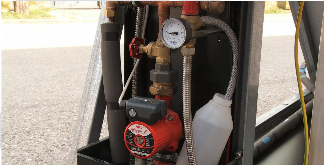
En instalaciones con circulación forzada se emplea un sistema de control diferencial de temperatura, que será el encargado de activar la bomba, en función de la diferencia de temperatura entre la salida de los captadores y el subsistema de acumulación.
