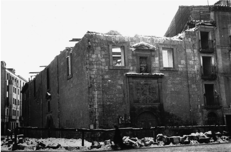
Fig. 7. Derribo del convento de las Luisas en la Plaza Vega. AMBu.
