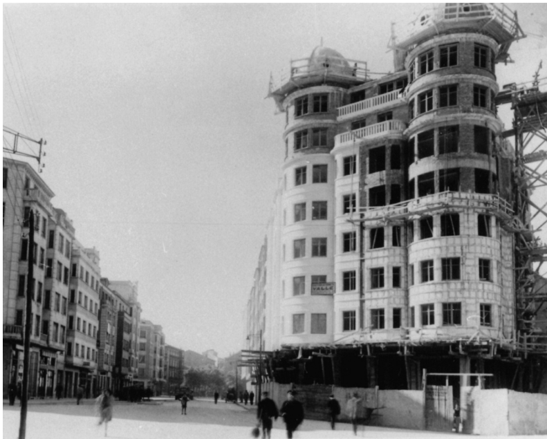
Fig. 8. Construcción del edificio proyectado por Martín Tárrega, 1945. AMBu.
