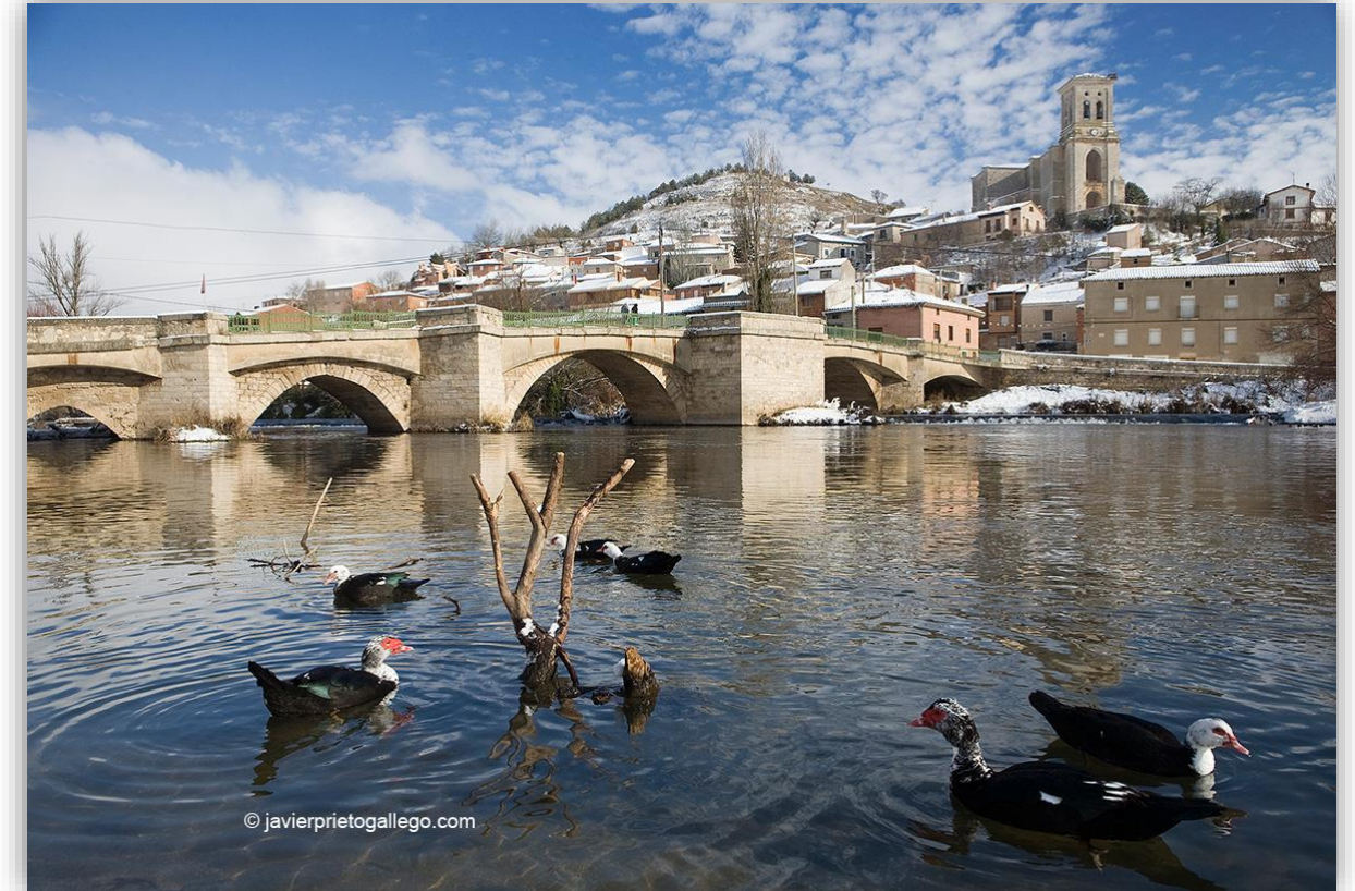
Ilustración 1: Paso del Puente Medieval, Pampliega
