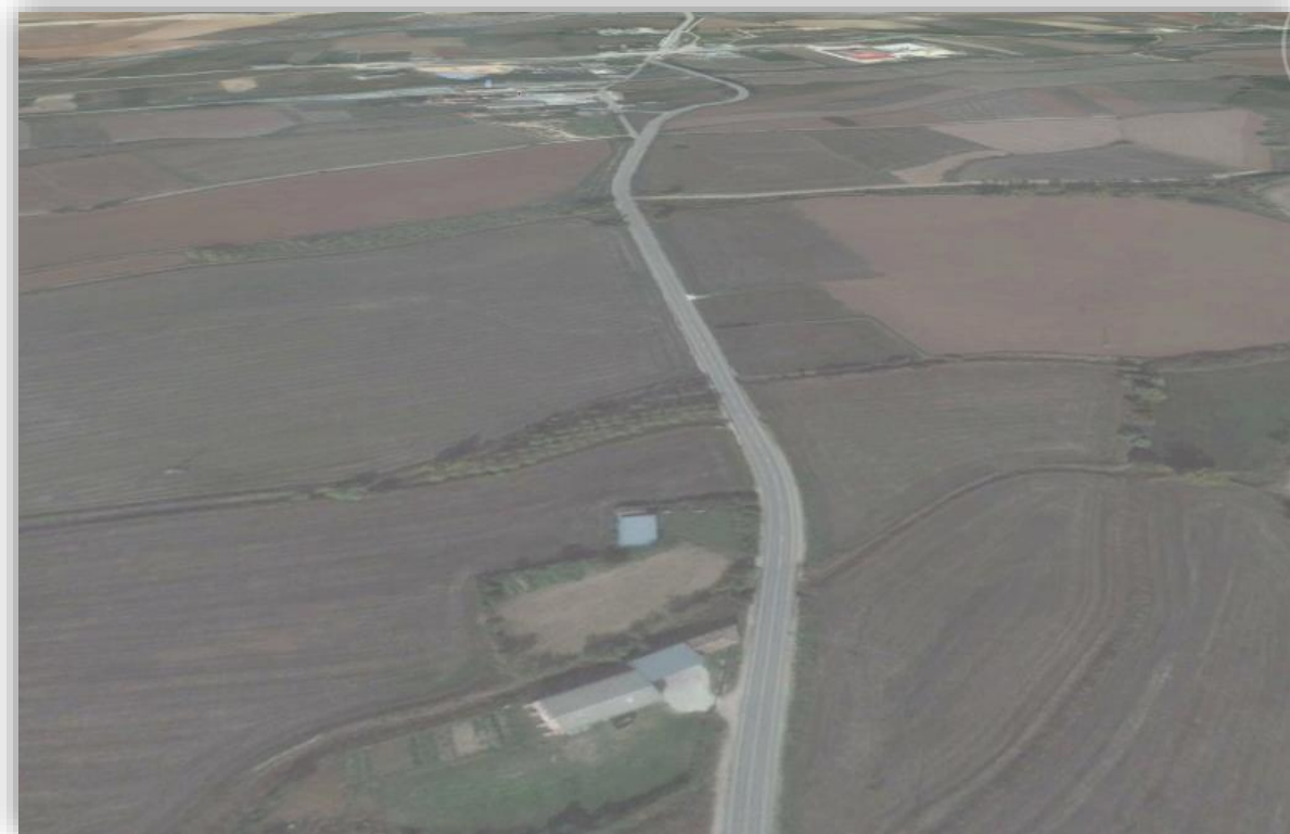
Ilustración 3: Situación de la Carretera BU-101
