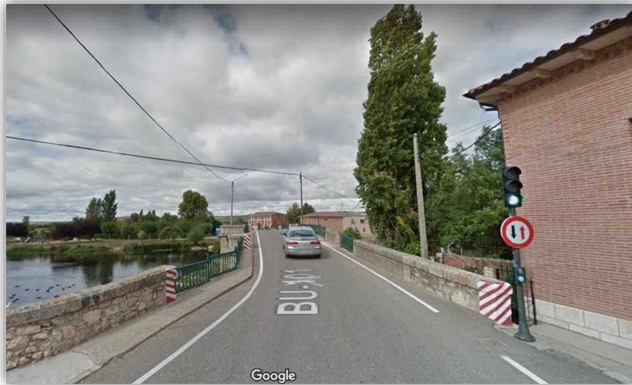
Ilustración 1: Semáforo antes del puente
