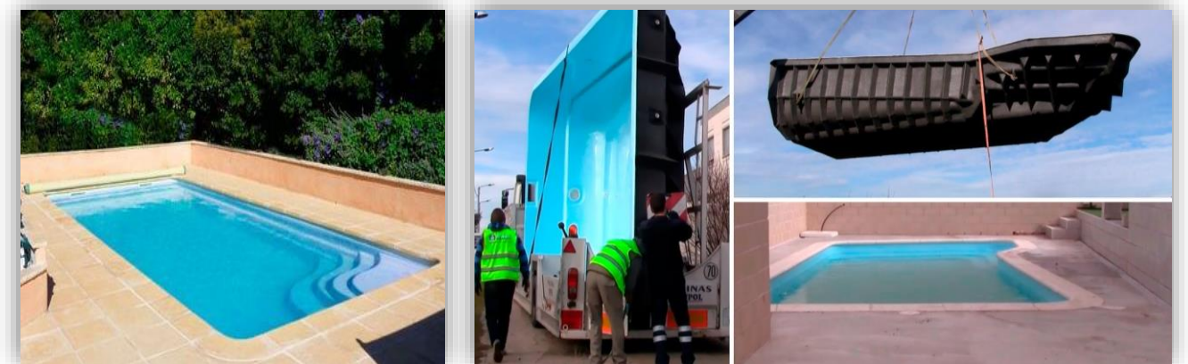
Ilustración 4: colocación de piscina prefabricada "tipo"
