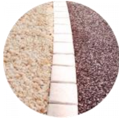
Ilustración 3: unión con adoquines y otro pavimento.
