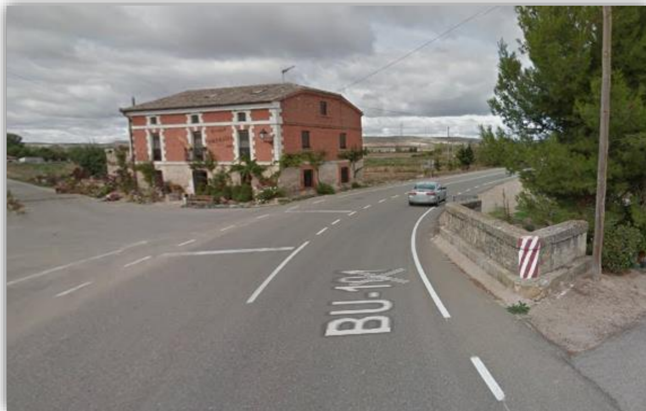
Ilustración 3: Curva a la salida del Puente medieval, dirección "Autovía Castilla"
