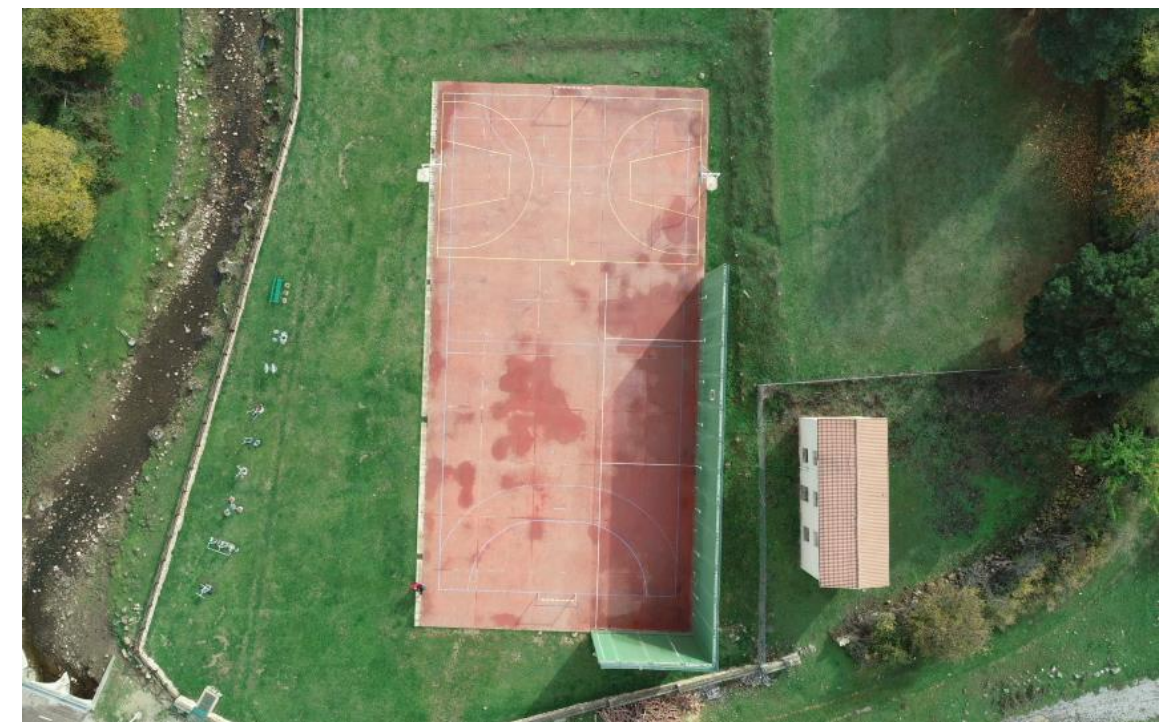
Ilustración 3: Vista Cenital de la pista, donde se aprecian las humedades de pistas mencionadas
