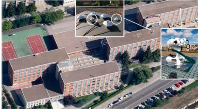
Figura 3. Ubicación del equipo experimental en la azotea de la Escuela Politécnica Superior edificio de la Universidad de Burgos, España [47].
