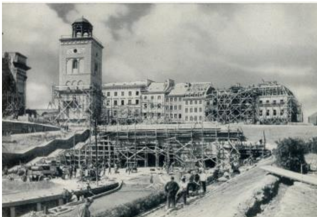
Fig. 49: Vista de la construcción de Trasa W-Z en el tramo de la plaza Zamkowsky.
