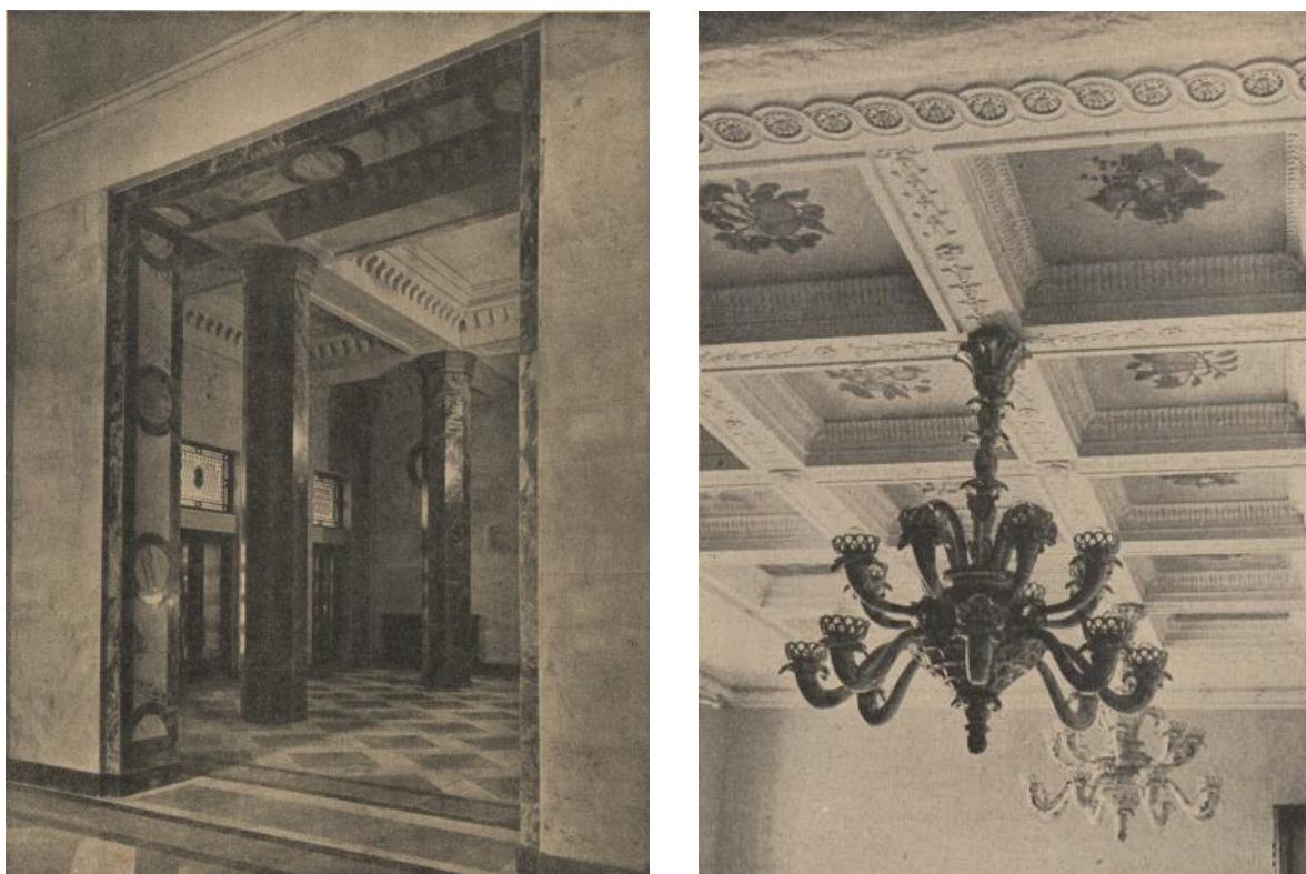
Fig. 138. M.F. 22: Interior del Palacio de Cultura. Hall principal. Techo con casetones y candelabros del Teatro, entrada a la Sala de Conciertos, Sala del Invierno, 1955.
