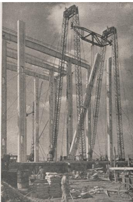
Fig. 45: Instalación de elementos prefabricados pesados, 1954.
