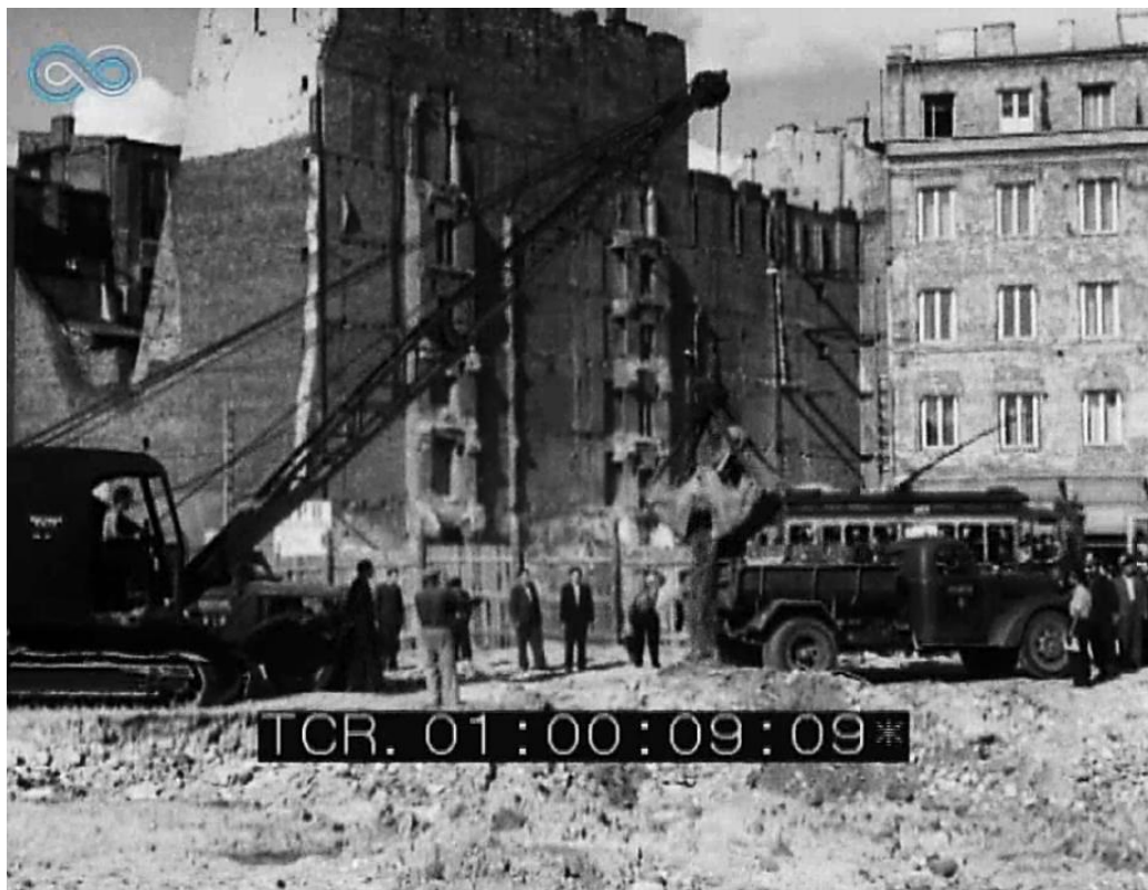
Fig. 47: Uso de grandes máquinas en la construcción de MDM
