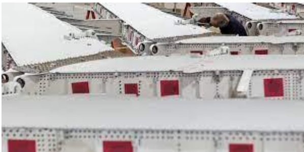
Ilustración 6 Montaje de HTP. Fuente: Aciturri
