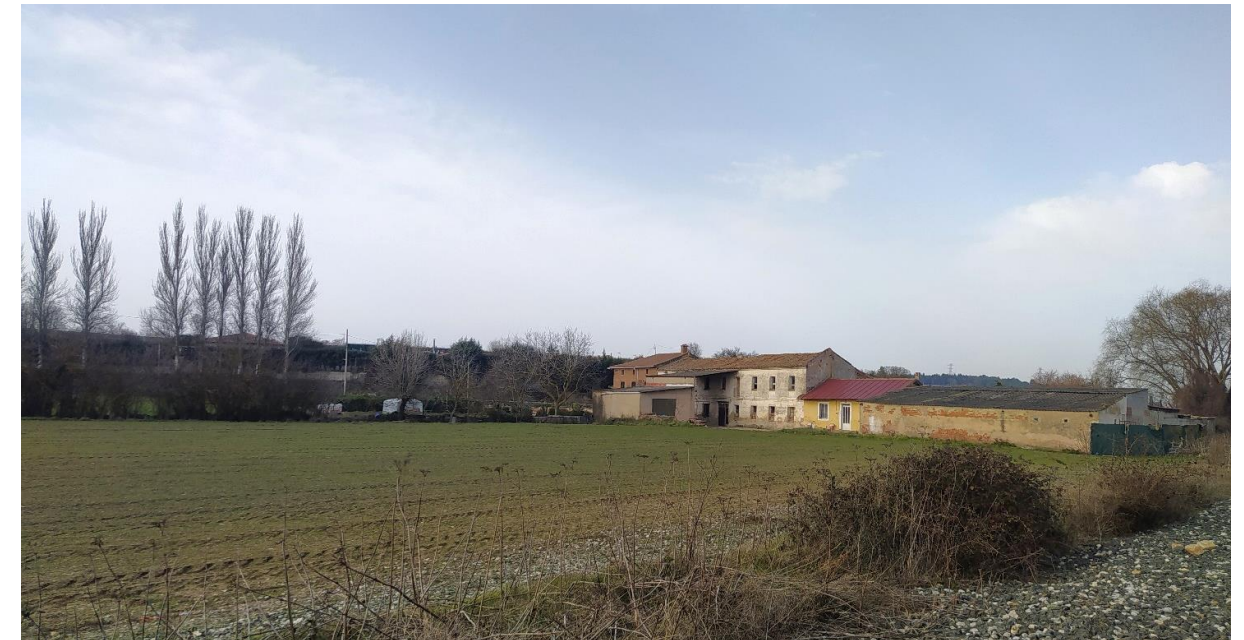
Imagen 13 Edificaciones junto a la antigua línea ferroviaria
