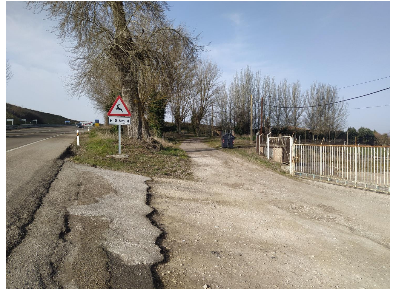
Imagen 14 Red de telecomunicaciones sobre postes de madera
