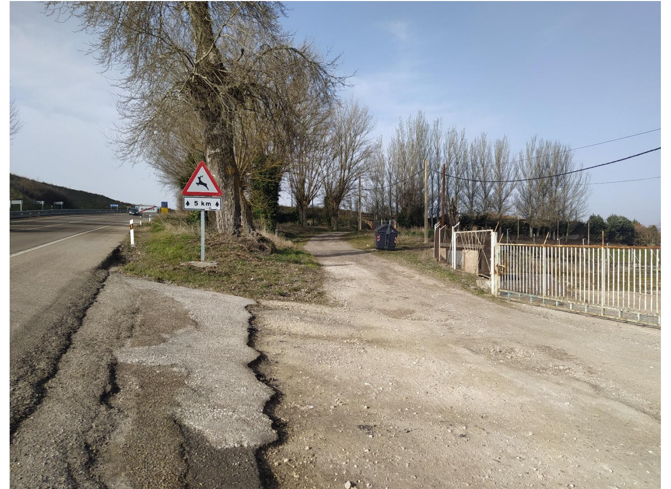
Imagen 14 Red de telecomunicaciones sobre postes de madera
