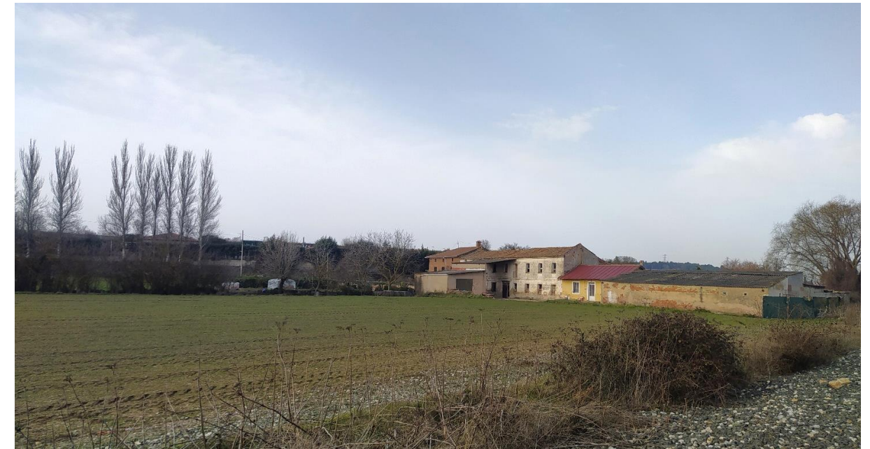
Imagen 13 Edificaciones junto a la antigua línea ferroviaria
