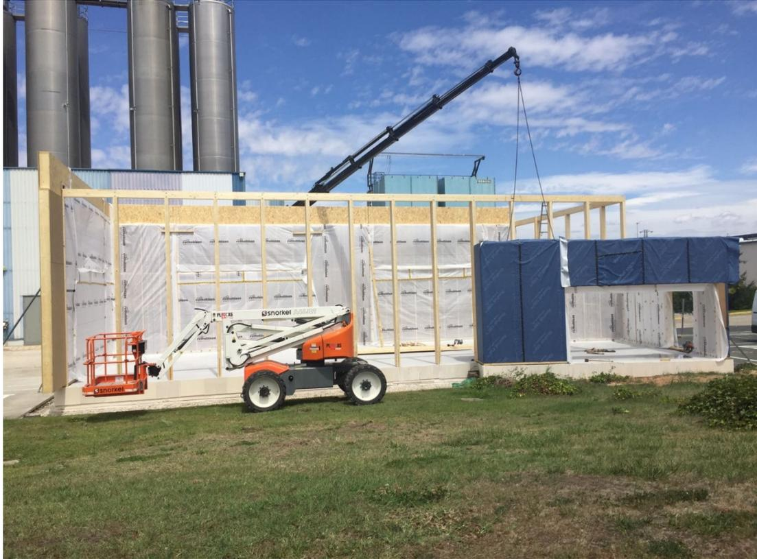
*Figura 158. 3- Montaje de la envolvente*
