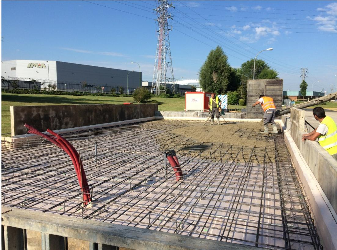
*Figura 156. 1- Solera Hormigón*
