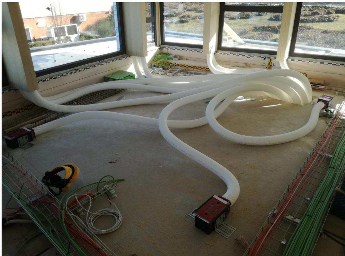
*Figura 168. Conductos de ventilación de los aseos*
