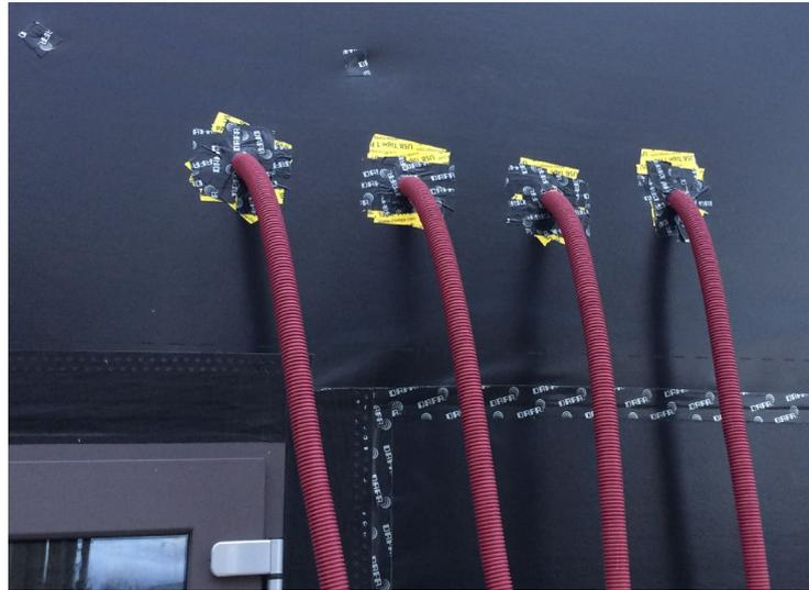
Figura 40. Detalle de la hermeticidad de los conductos de instalaciones y los defectos
