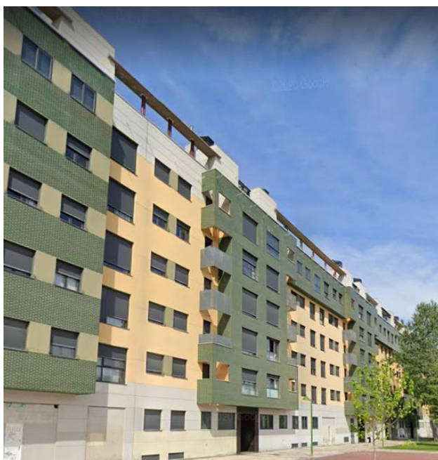
Figura 11. Fachada 1, imagen de Google maps.
