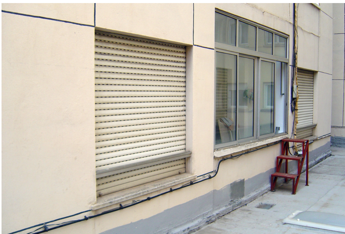
Detalle de la fachada de ladrillo enfoscado.
