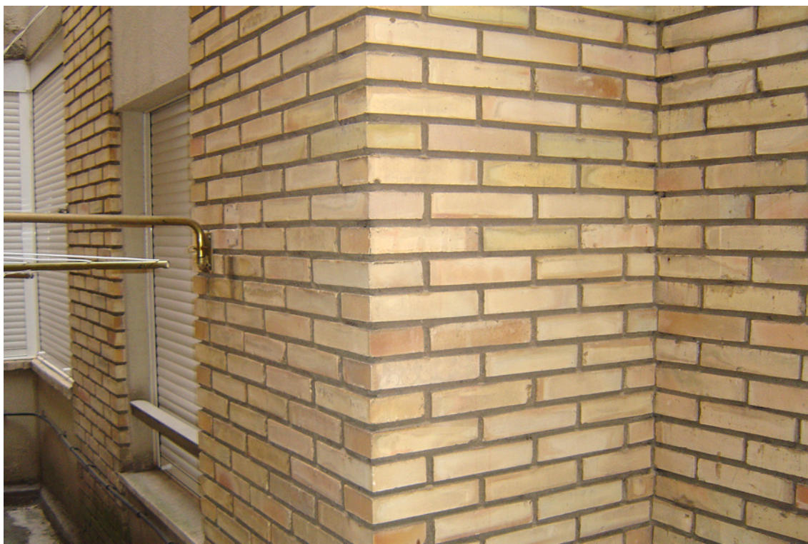
Detalle de la fachada de ladrillo cara vista.
