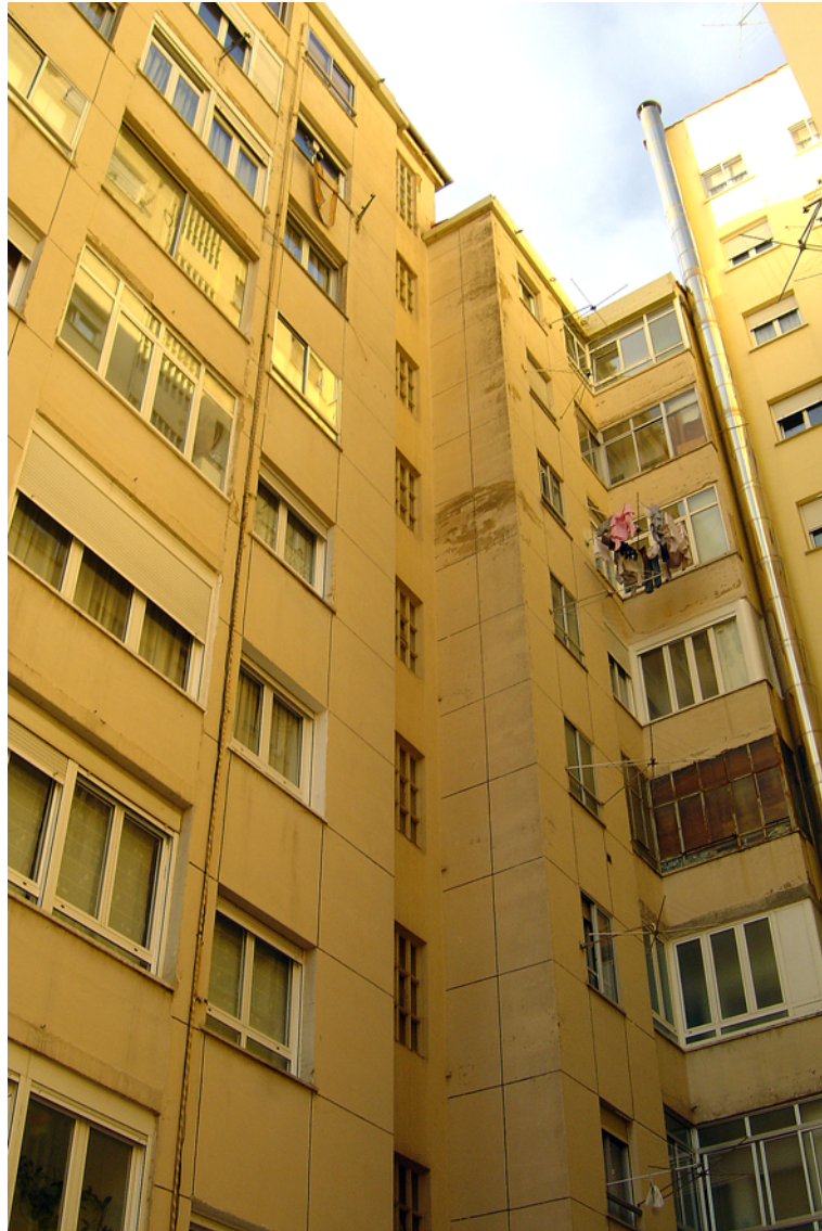
Fachada lateral izquierda y fachada posterior junto al edificio del Carmen 4.
