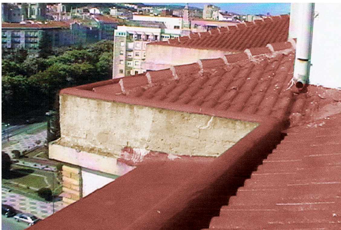
Detalle de la cubierta inclinada y de la cubierta plana sobre una terraza.
