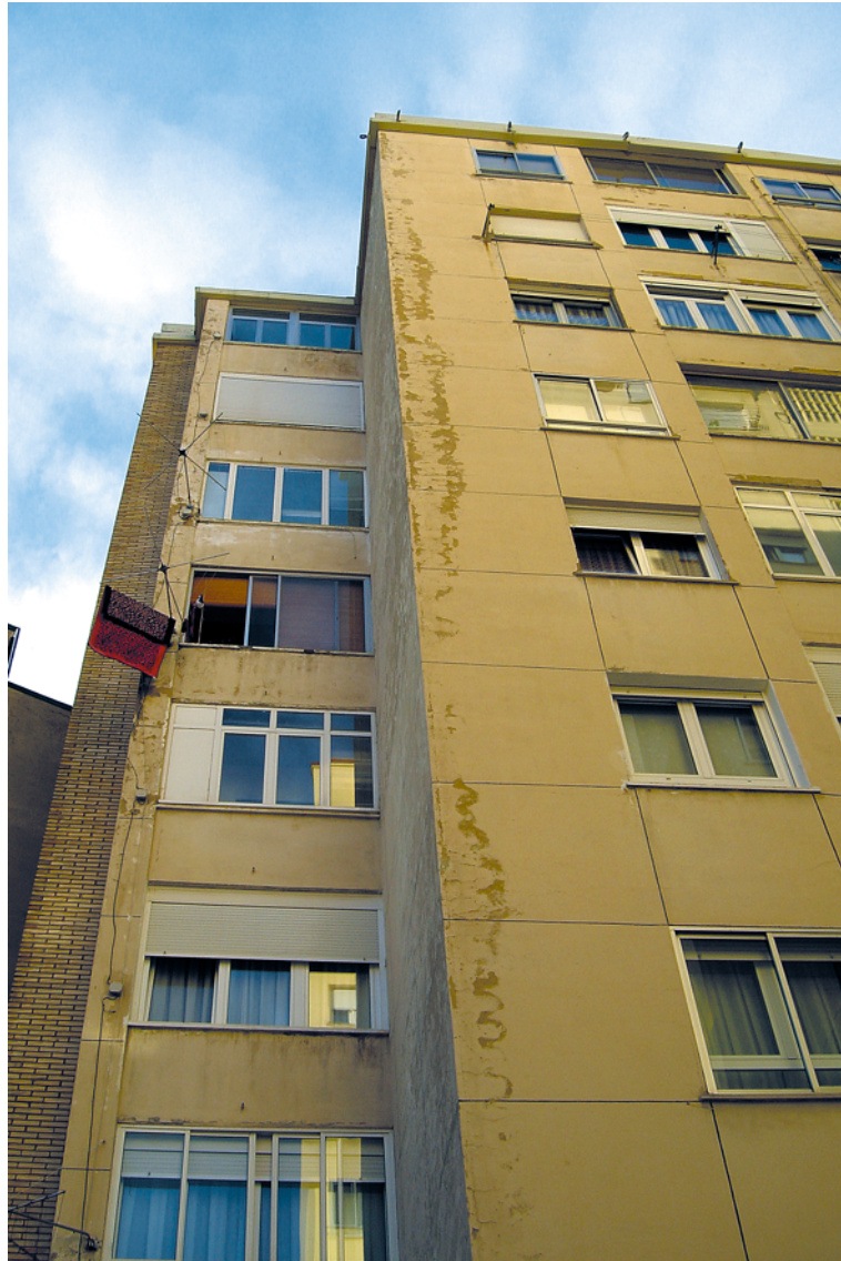
Fachada lateral izquierda desde la fachada posterior.
