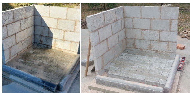
Figura 9.3 Proceso de ejecución del demostrador (julio 2023)
