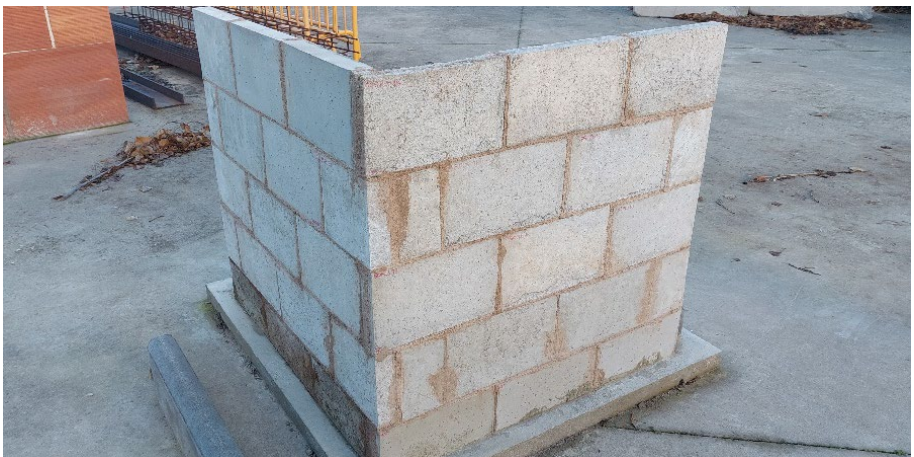
Figura A1.9 Aspecto general 22 de diciembre 2023
