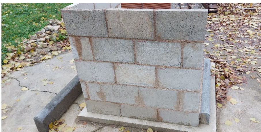
Figura A1.8 Aspecto general 11 de diciembre 2023
