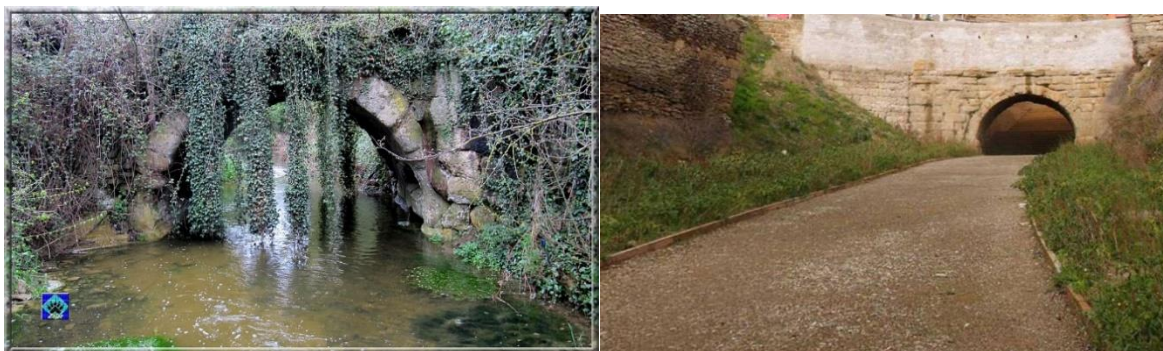
Figuras 8 y 9. A la izquierda el puente de San García, a la derecha el de San Ciprián
