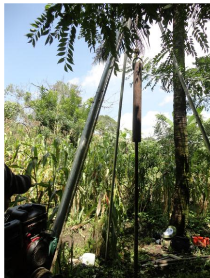
Figura 6: Trepano empezando a penetrar en el terreno (fuente archivo propio)
