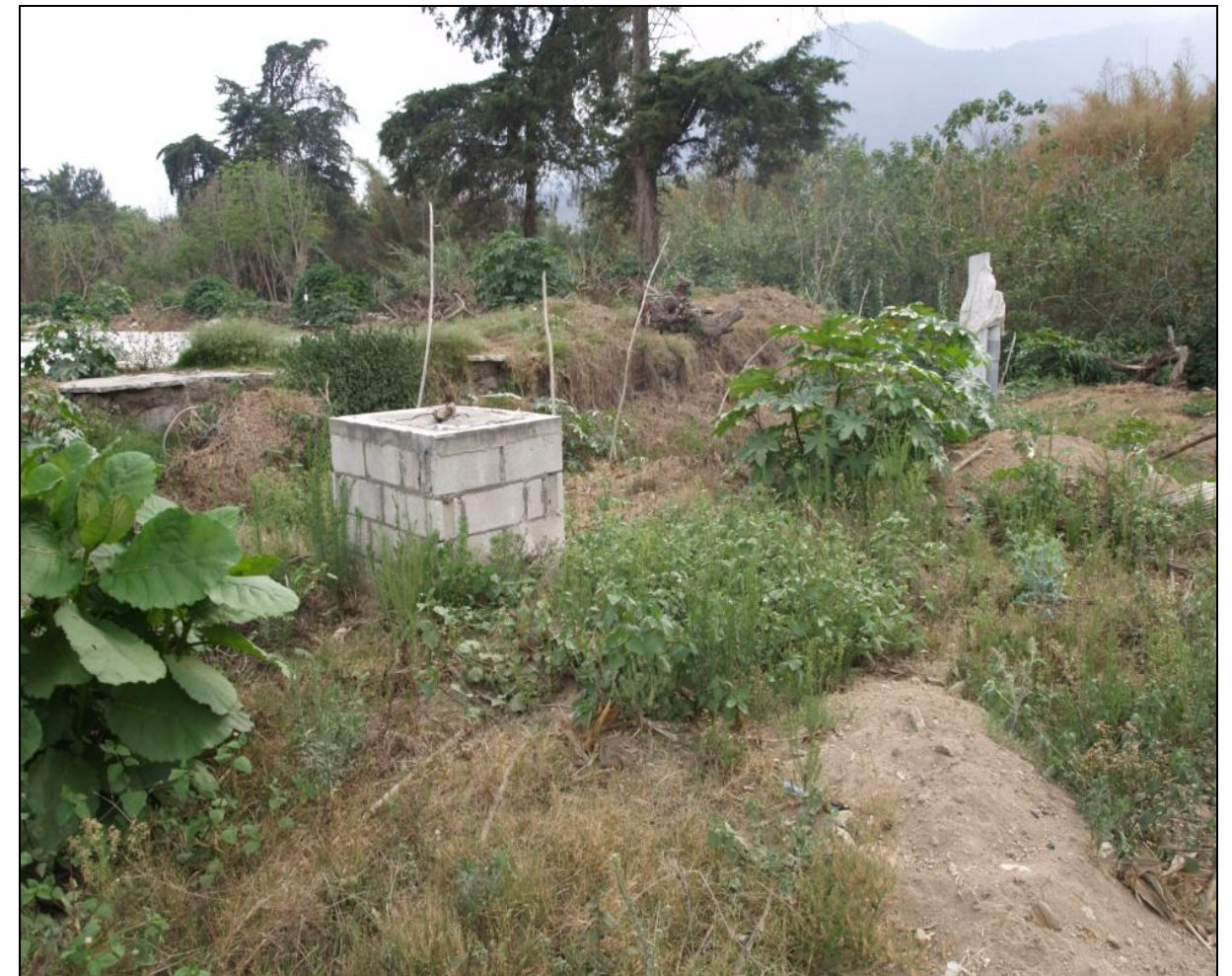
Situación actual de la Planta de Tratamiento de Aguas Residuales.
