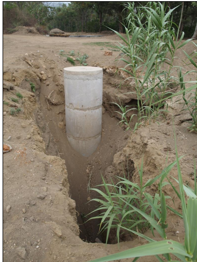
Pozo de visita.
