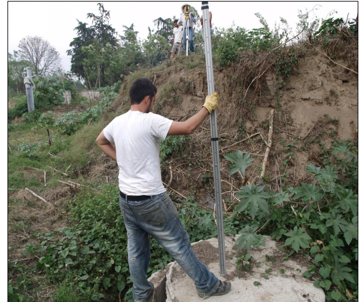
Levantamiento topográfico in situ.
