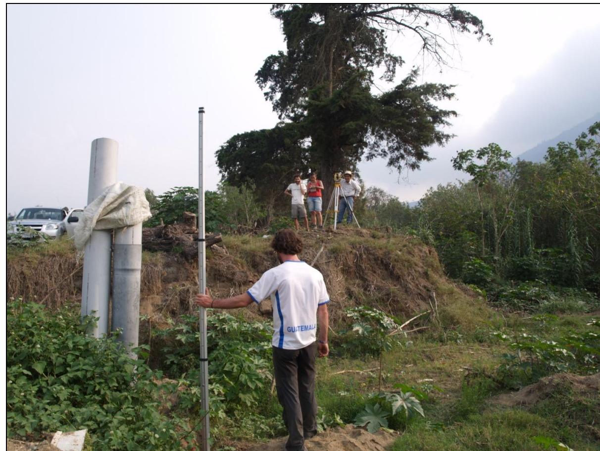
Levantamiento topográfico in situ.
