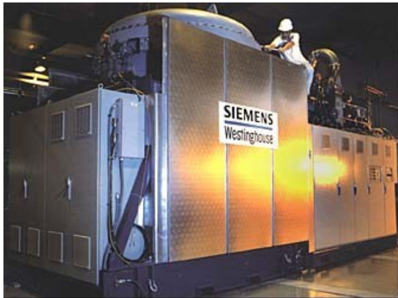
Figura 11: Siemens-Westinghouse, que es una planta de energía que combina las fuel cell con una turbina de gas, convirtiéndose en una de las técnicas más limpias para generar electricidad, ya que no requiere de la combustión.
