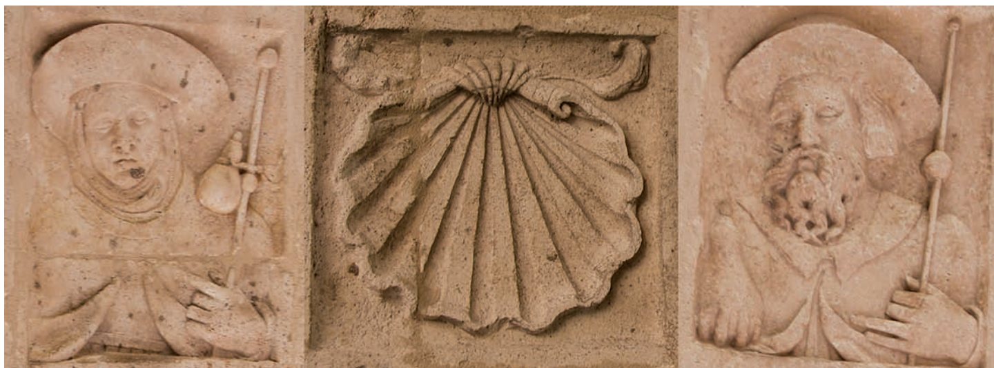
Detalles del Arco de medio punto de la Puerta del Refectorio de Peregrinos, Siglo XVI. Patio de los Romeros (Hospital del Rey)
