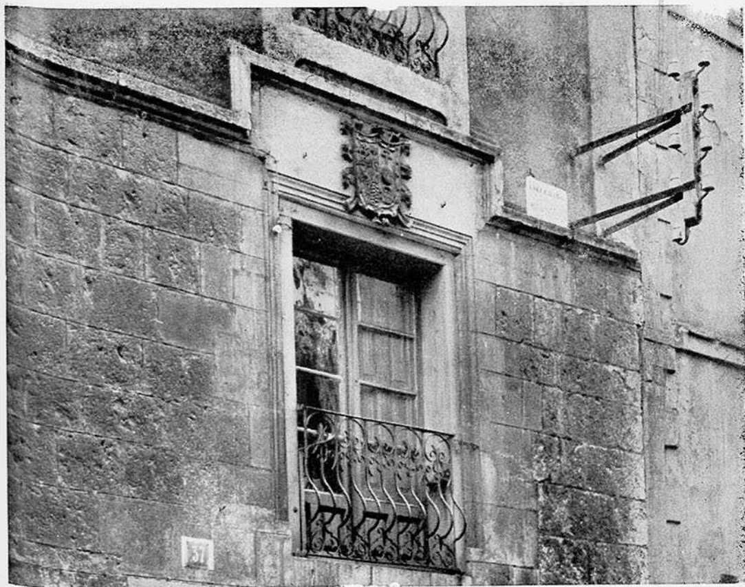
Grupo principal de la antigua casa solariega de los Presa, sita en la calle de la Puebla, actual número 37.
