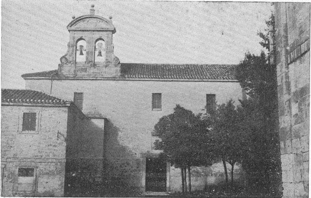
LERMA. —Interior de la capilla de las Clarisas » Fachada del convento de las Clarisas
