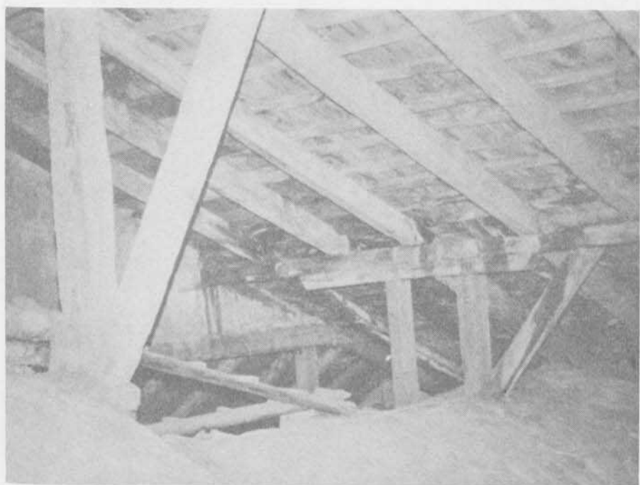
Figuras 5 y 6.—Ruinas, remiendos y apeos en la propia bóveda en la Capilla de Santa Ana
