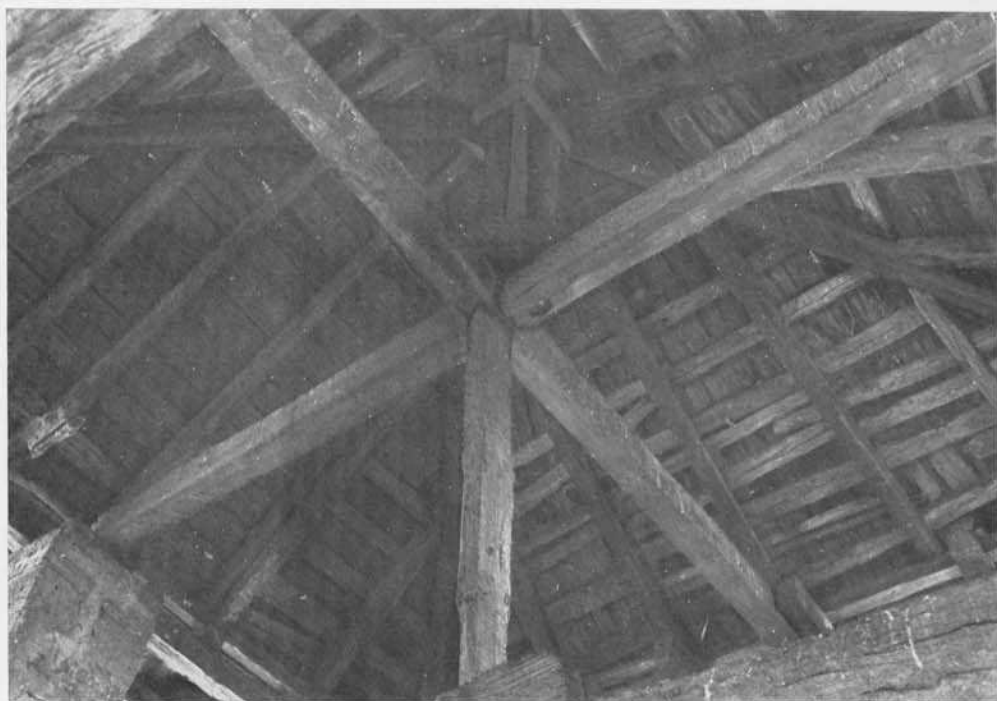
Lám. VII. — Armadura a cuatro aguas que cubre la torre
