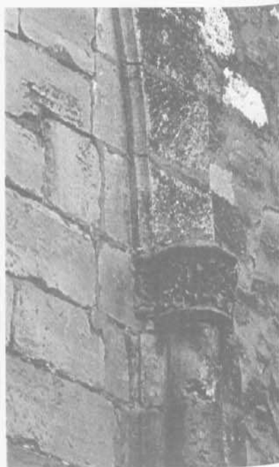
Foto 8. – Pilastra de arranque de bóveda.
