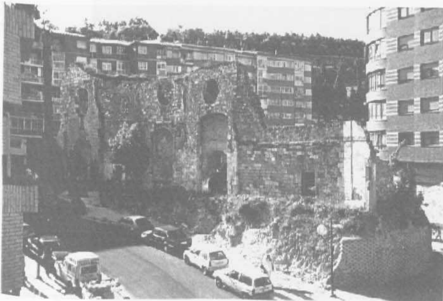
Foto 2. – Berma de tierra que sujeta y contiene la pared norte de la Iglesia.
