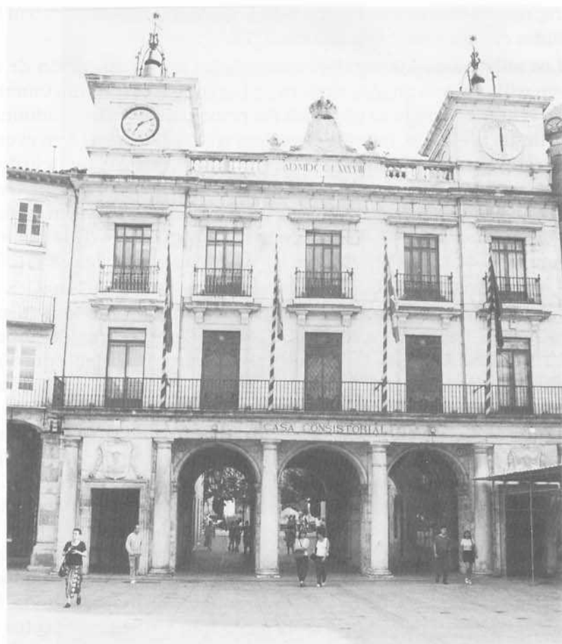
Vista de la fachada principal de las nuevas Casas Consistoriales.
