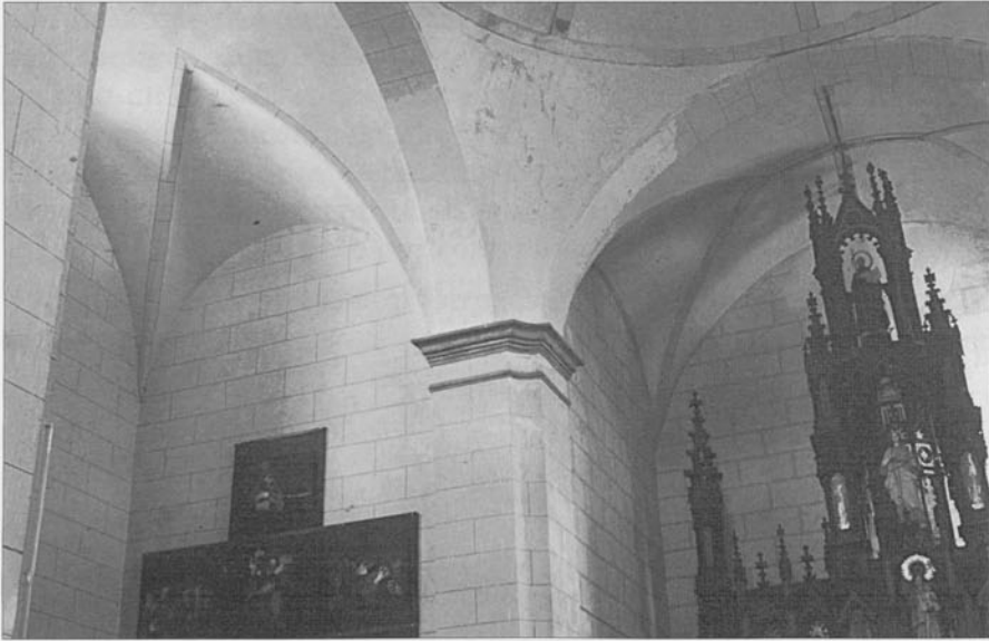
Fig. 10: Interior de la iglesia de Santa Juliana de Entrambasaguas
