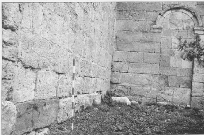
Pieza del acueducto reaprovechada en la parte inferior del muro de la iglesia de Olmillos
