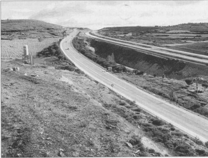
Vista general del lugar de los Anillos, lugar donde aparecieron el mayor número de piezas del acueducto con motivo de las obras de la autovía Burgos-León que se observa junto a la carretera N-120
