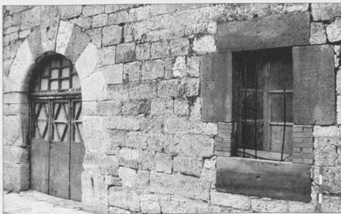
Varias piezas reaprovechadas en una edificación de Olmillos. Se observa la huella de la tenaza de elevación
