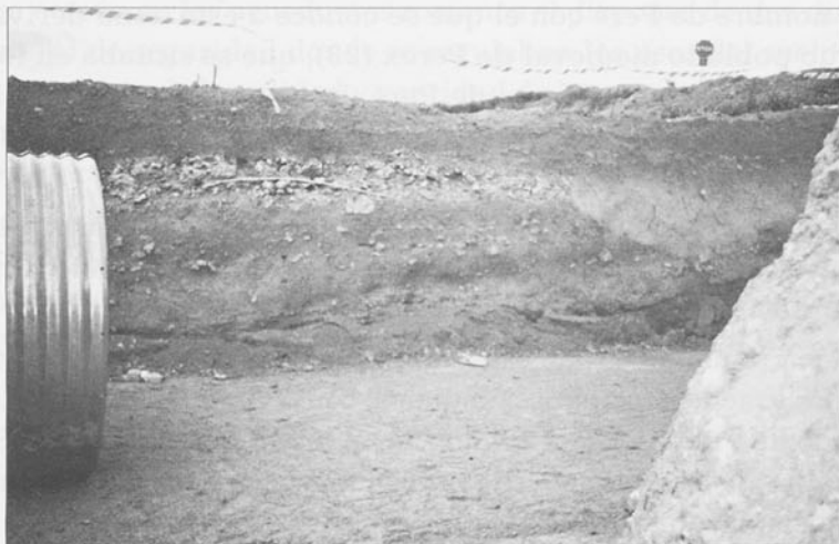
Sección de la infraestructura de la vía romana bajo el Camino Viejo de Burgos, en la excavación de un drenaje transversal, en las obras de la autovía Burgos-León, en Olmillos de Sasamón
