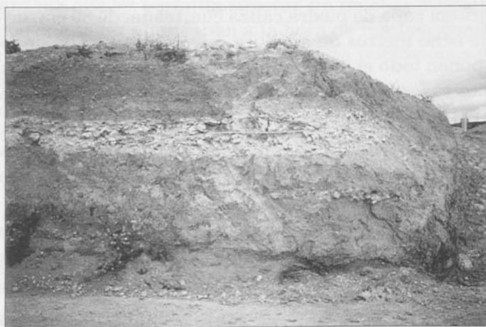
Otra sección de la infraestructura de la vía romana bajo el Camino Viejo de Burgos, en las obras de la autovía Burgos-León
