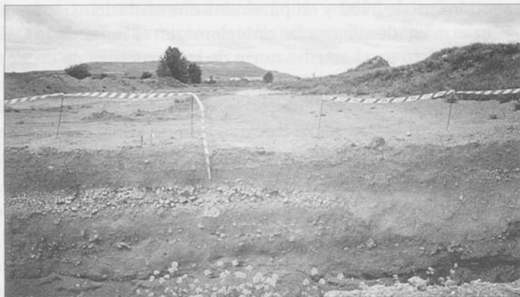
Sección de la infraestructura de la vía romana en la excavación de las obras de la autovía Burgos-León. Al fondo, Olmillos de Sasamón
