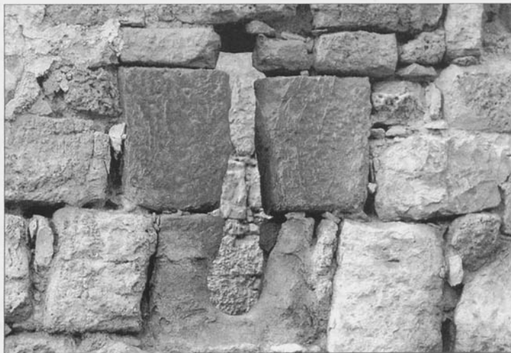
Trozos de canal reaprovechados en la tronera del castillo de Ommillos de Sasamón
