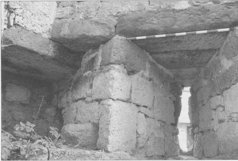
Pieza del canal reaprovechada en el dintel de la tronera del castillo de Olmillos de Sasamón. Se observa la huella de la tenaza de elevación
