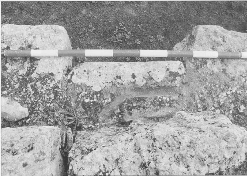
Trozo del canal reaprovechado en las almenas del castillo de Olmillos de Sasamón. Se observa el canalillo de la junta estanca de unión entre piezas
