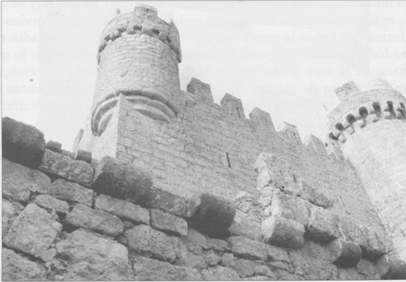
Trozos de acueducto reaprovechados en el castillo de Olmillos de Sasamón
