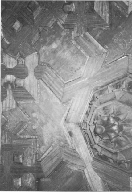
Lerma. Iglesia de la Piedad. Almizate de la armadura mohamares del tramo de limas central de la cabecera. Comienzos del siglo XV
