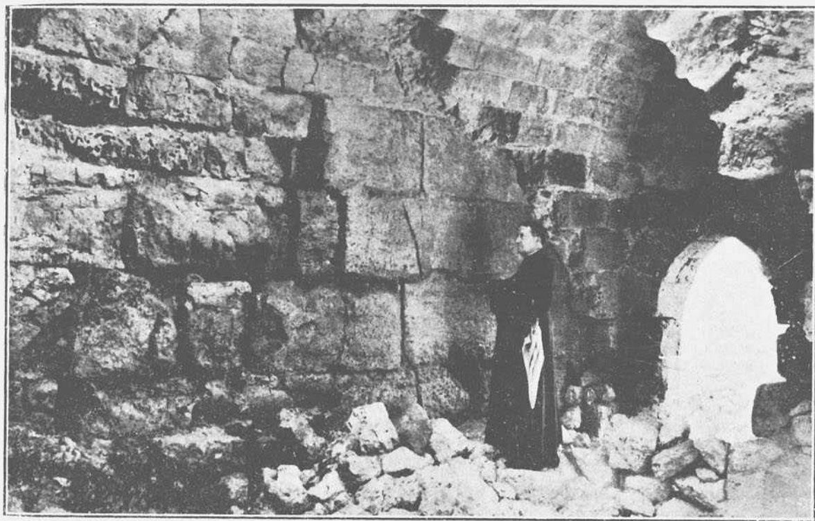
Fot. núm. 1. Castrojeriz: Restos del arco romano
