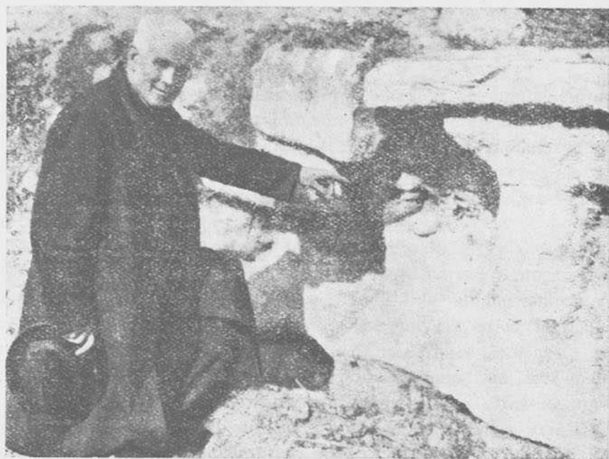
Fot. n.º 1.—CEREZO DE RÍO TIRÓN. Muro de contención de la vía Tarragona-Astorga a la entrada del puente romano.
