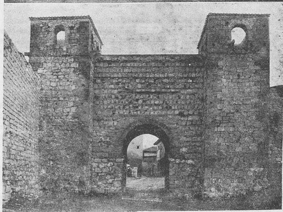
Arriba: Estructura primitiva del Arco de San Esteban. Abajo: El Arco en la actualidad.
