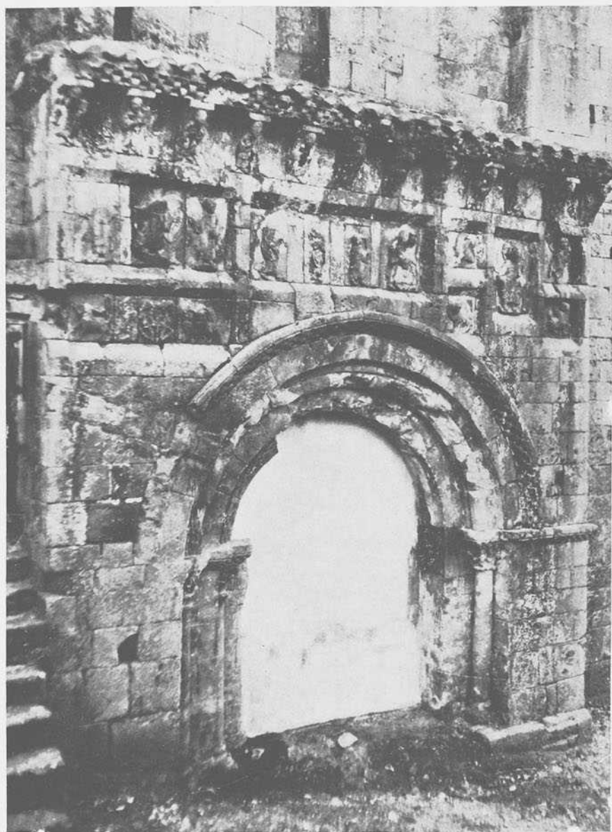
Fot. núm. 3.—Portada de la Ex-colegiata de San Quirce, nuevamente descubierta.
