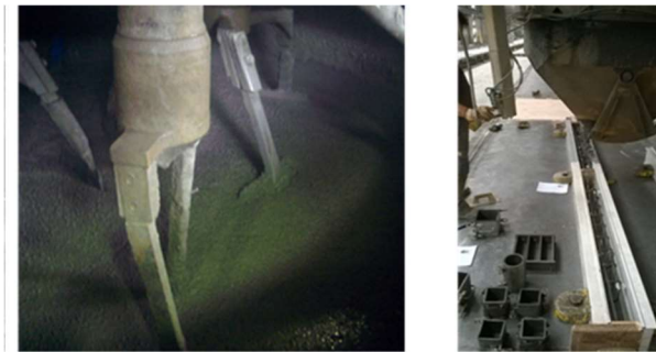
Figura 6 Amasado del lote. Hormigonado de las piezas con RCA
