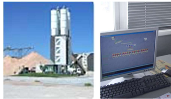
Figura 5 Central hormigonado y automática.
