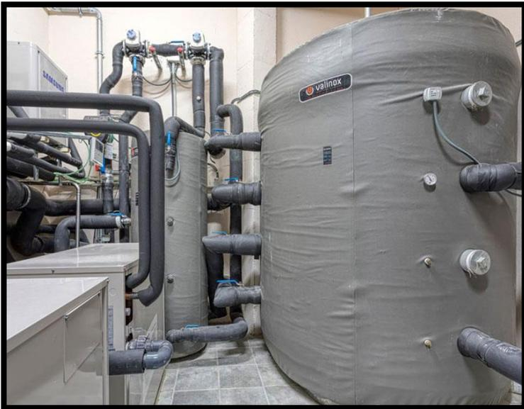
**Figura 49. Instalación geotérmica.**
