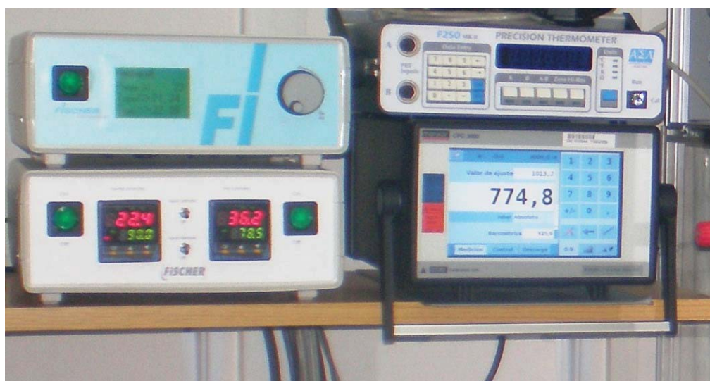
Figura 3.5 Sistemas de control y medida de temperatura y presión del equipo VLE 602S.
