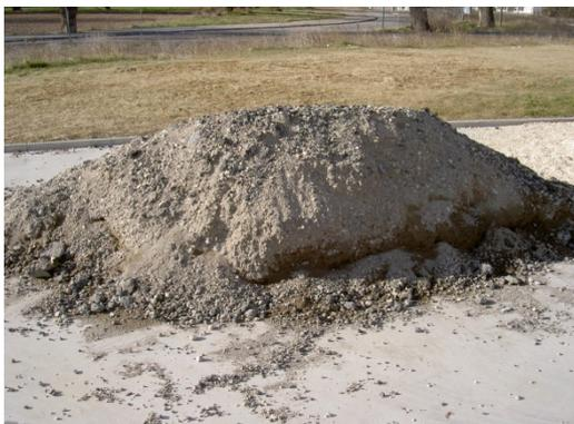
Foto 35. Material procedente de fresado de firme en acopio exterior
