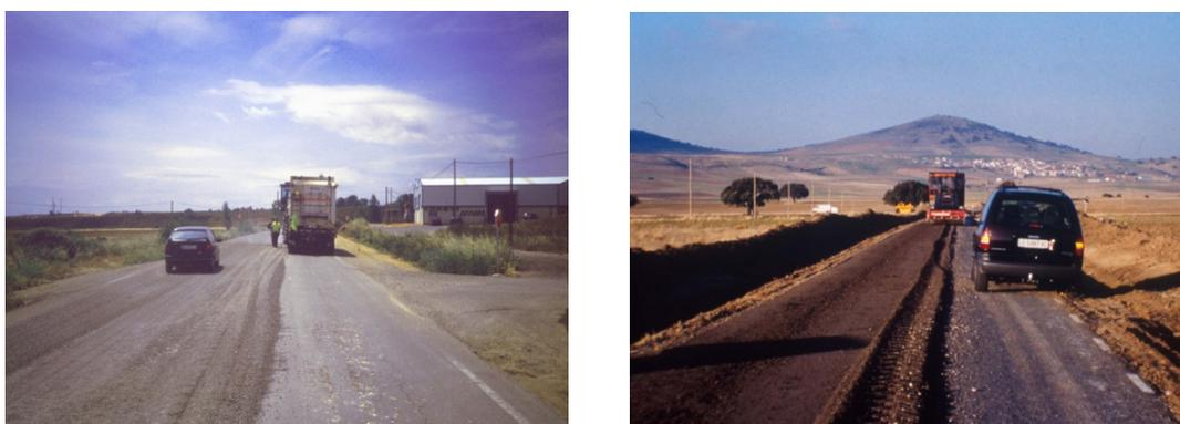
Fotos 27 y 28. Realización del reciclado con tráfico
