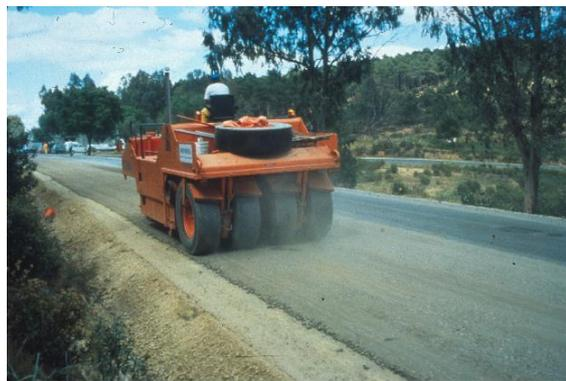
Foto 32. Terminación con compactador de neumáticos. Cáceres. 1995
