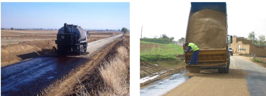
Fotos 33 y 34. Riego de curado y protección con árido
