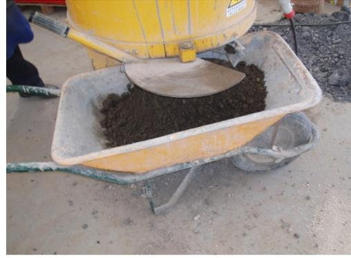
Foto 76. Vertido del material mezclado sobre la carretilla
