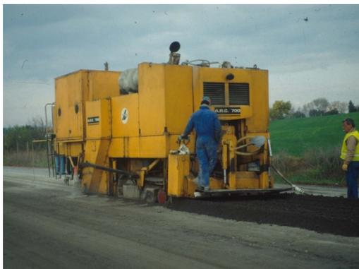
Foto 9. Recicladora Beugnet con cámara de mezclado
