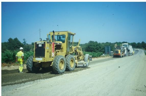
Foto 26. Refino con motoniveladora. Barcelona. 2001
