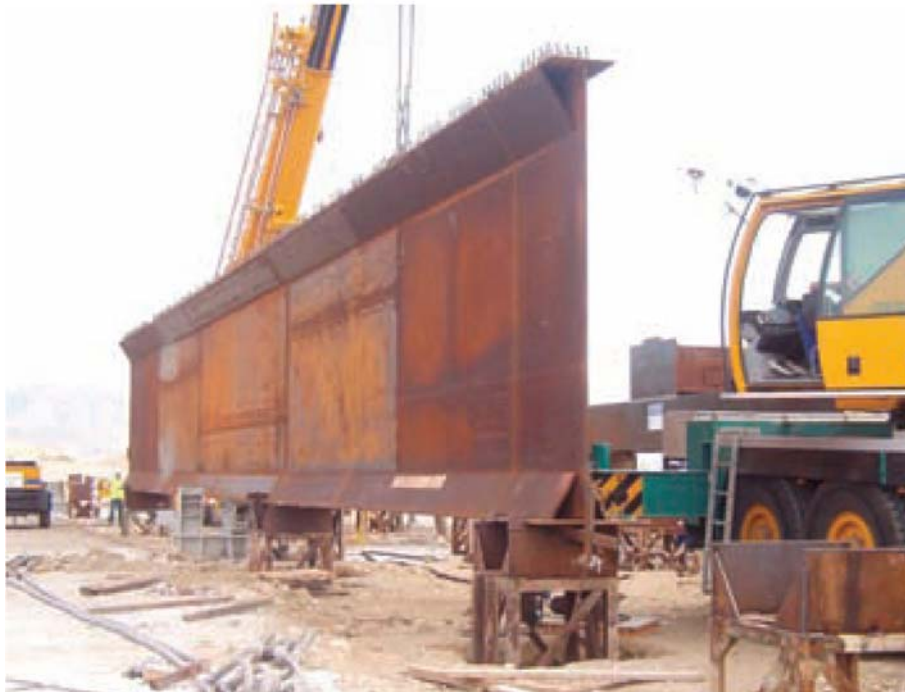
Figura 2. 2. Viga armada con "células triangulares" a la altura de las alas, [Millanes, 2007]
