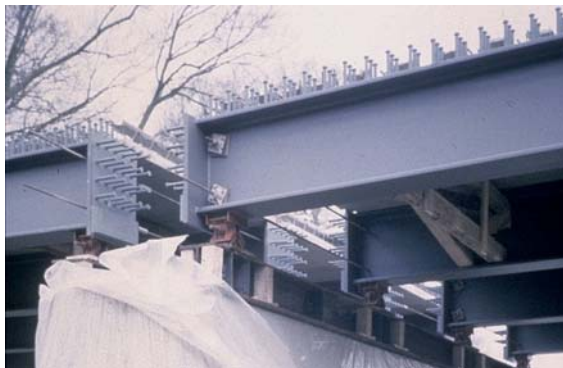
Figura 2. 11. Detalle de unión en apoyos del "Puente sobre el río "Oder" (Alemania), [Arcelor, 2007]
