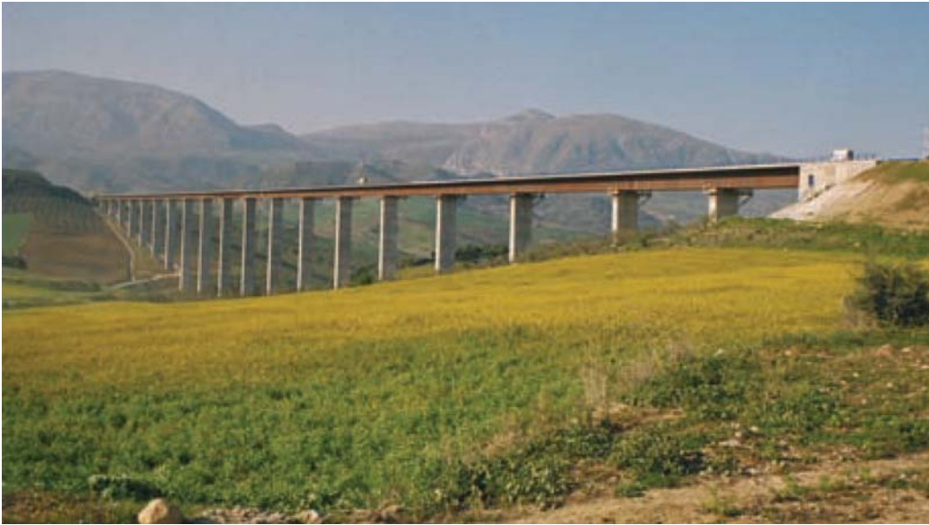
Figura 2. 4. "Viaducto Arroyo las Piedras" finalizado, [Millanes, 2007]
