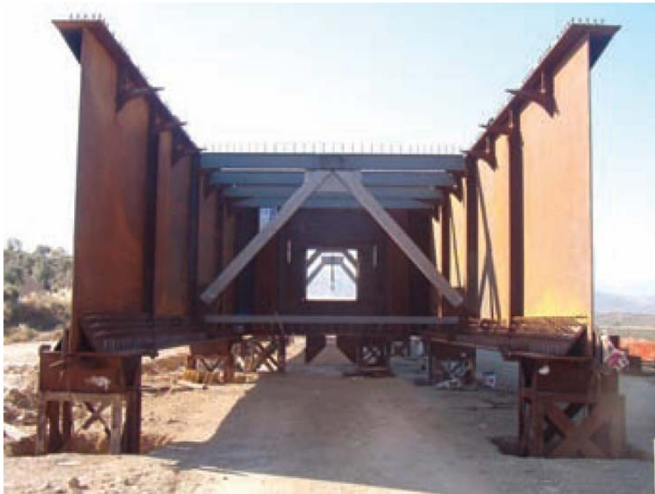
Figura 2. 1. Sección transversal del “Viaducto Arroyo las Piedras”, [Millanes, 2007]
