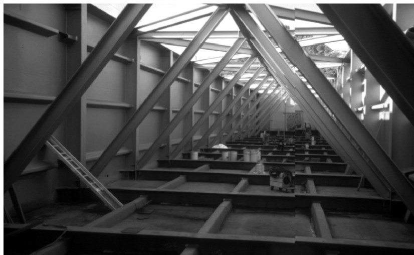
Figura 2. 8. Interior de la sección en cajón, [Martínez Cutillas, 2001].
