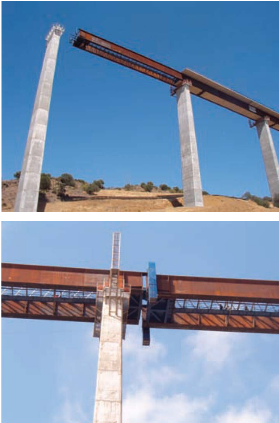
Figura 2. 3. Empuje del puente y unión de tramos durante la construcción, [Millanes, 2007]
