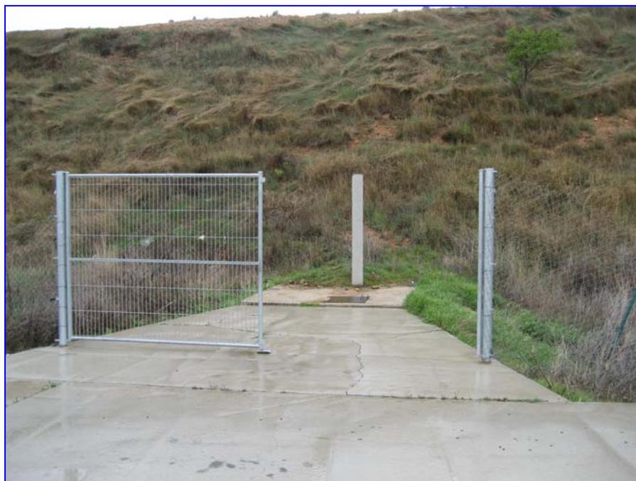
**Figura 3.36.** Lixiviados del vertedero. Almacenamiento en depósito de hormigón enterrado.
