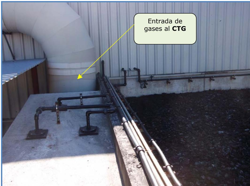
**Figura 3.5.** Sistema de conducción de los gases extraídos desde los túneles de fermentación al CTG. Red de riego del biofiltro
