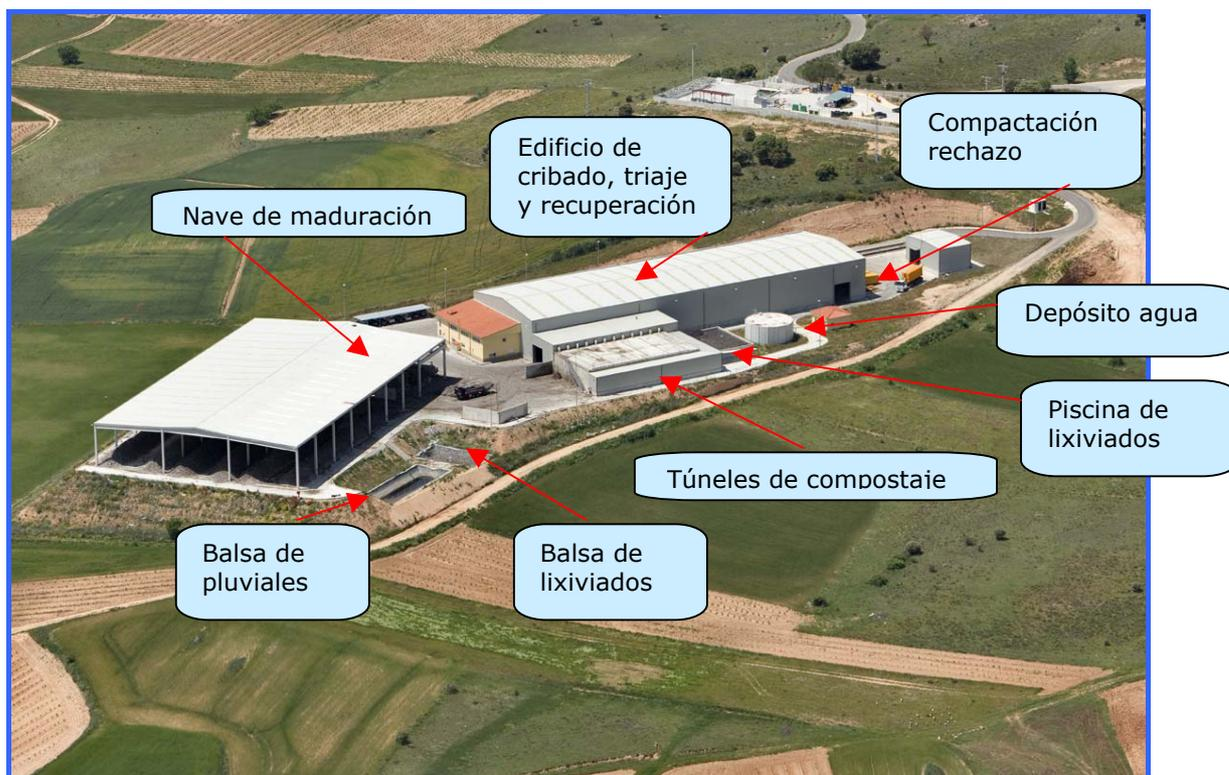
**Figura. 3.1.** Vista aérea del CTR de Aranda de Duero. Coloquialmente se le denomina planta de compostaje de Aranda.
