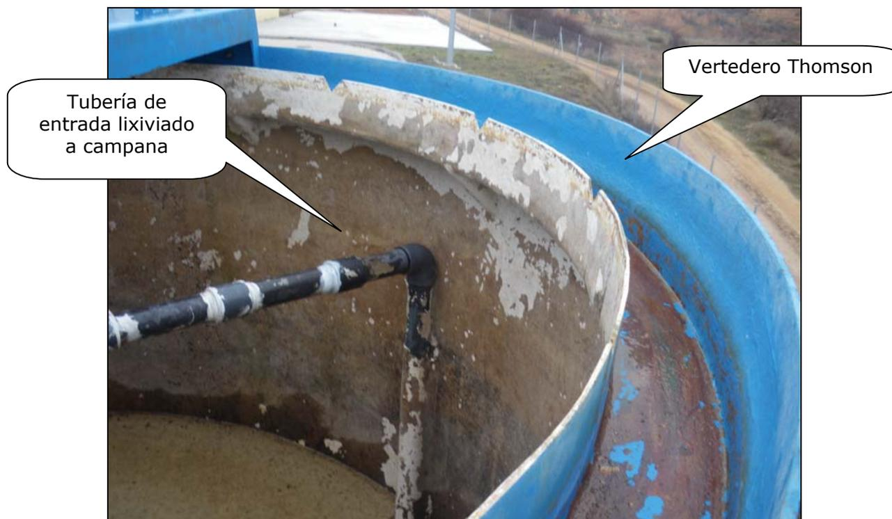
**Figura 3.35.** Vertedero del decantador
