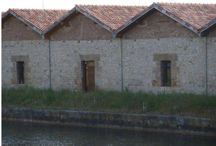
Ilustración 161. Almacén Grande de Alar del Rey (Palencia) tras su rehabilitación. Septiembre de 2010
