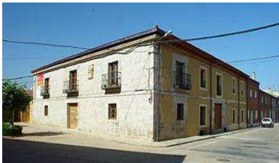
Ilustración 150. Casa de los Palazuelos en Melgar de Fernamental (Burgos)
