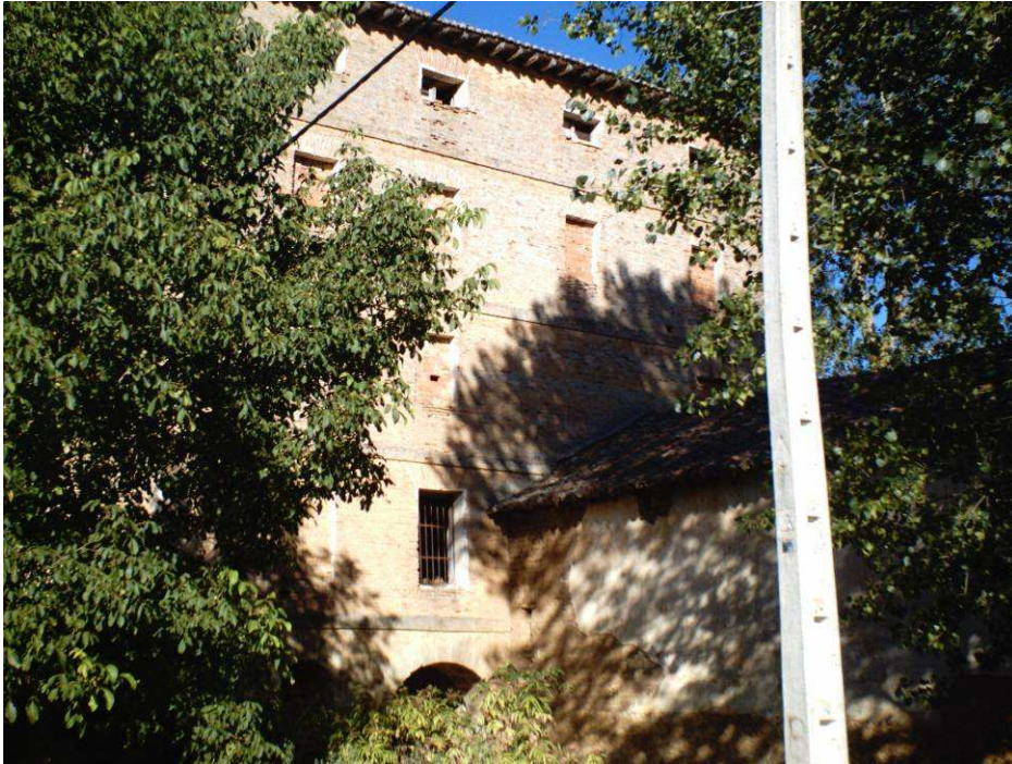
Ilustración 105. Fábrica del Puente en Melgar de Fernamental (Burgos)
