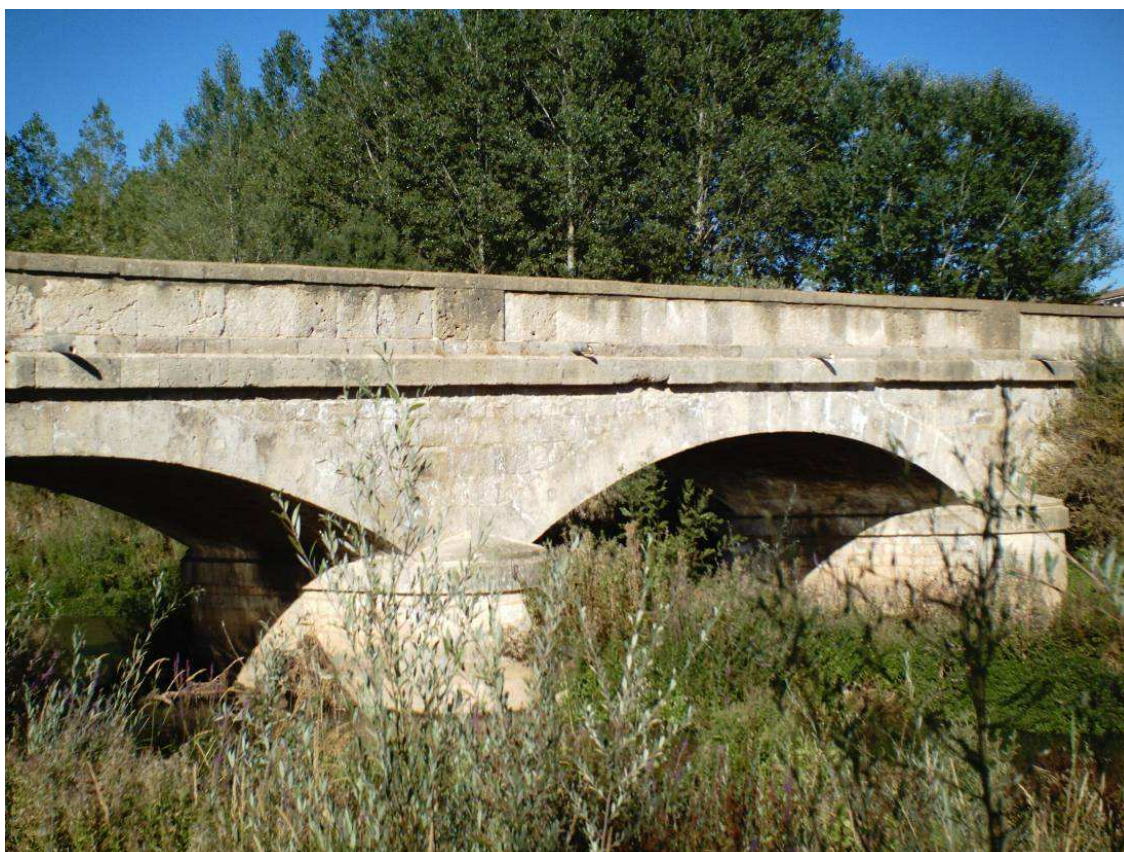
Ilustración 47. Puente sobre el Pisuerga en Melgar de Fernamental (Burgos)
