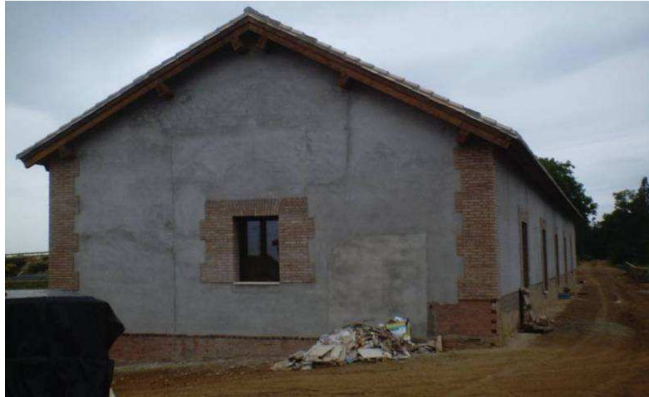
Ilustración 160. Acondicionamiento del almacén de Carrecalzada en Melgar de Fernamental, (Burgos). Junio de 2009
