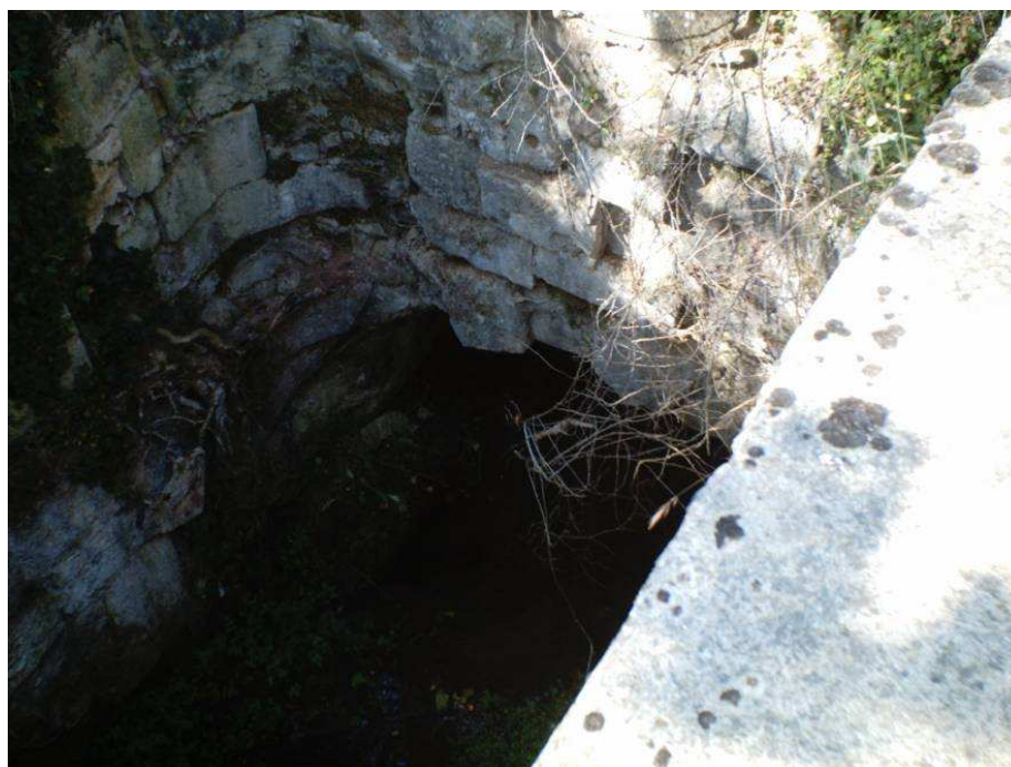
Ilustración 30. Alcantarilla del Pendón (Olmos de Pisuerga, Palencia)
