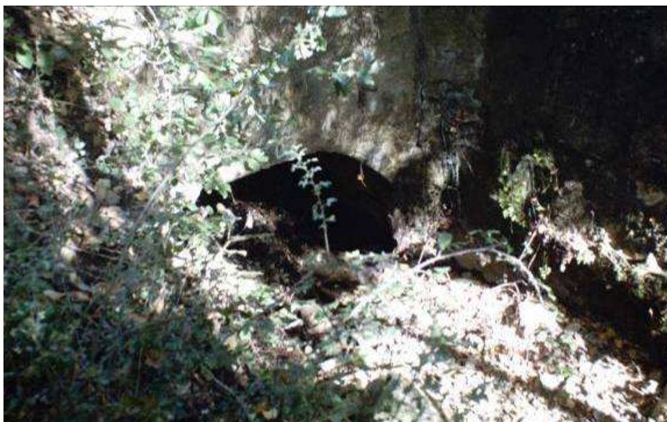
Ilustración 31. Acueducto de Valderramino (Melgar de Fernamental, Burgos)
