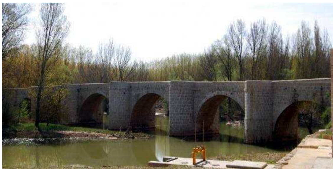
Ilustración 48. Puente sobre el Pisuerga en Lantadilla (Palencia)
