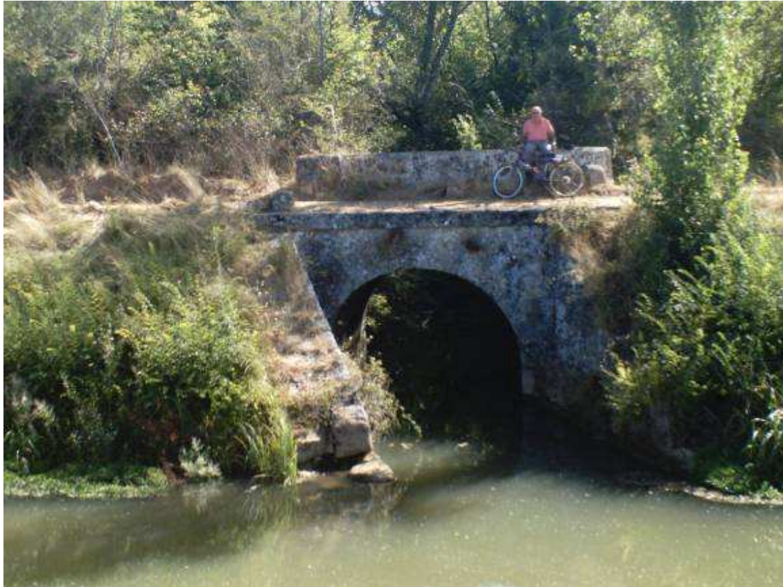
Ilustración 28. Puente en la derivación de las esclusas 11 y 12 (Olmos de Pisuerga, Palencia)
