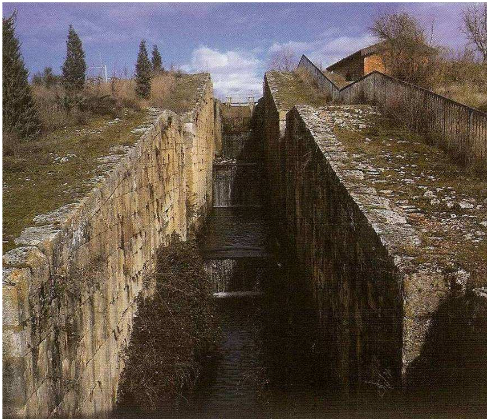
Ilustración 8. Esclusas 34, 35 y 36 del Ramal Sur (Villamuriel de Cerrato, Palencia)
